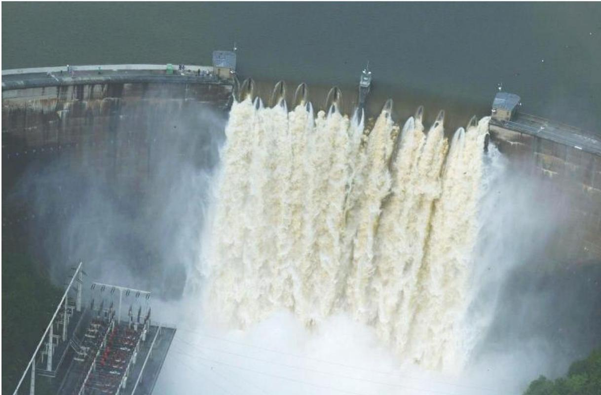
**Abb. 5.2** Klappenüberfall an der Sperre Ottenstein beim Hochwasser August 2002 (Foto: Österr. Bundesheer).
