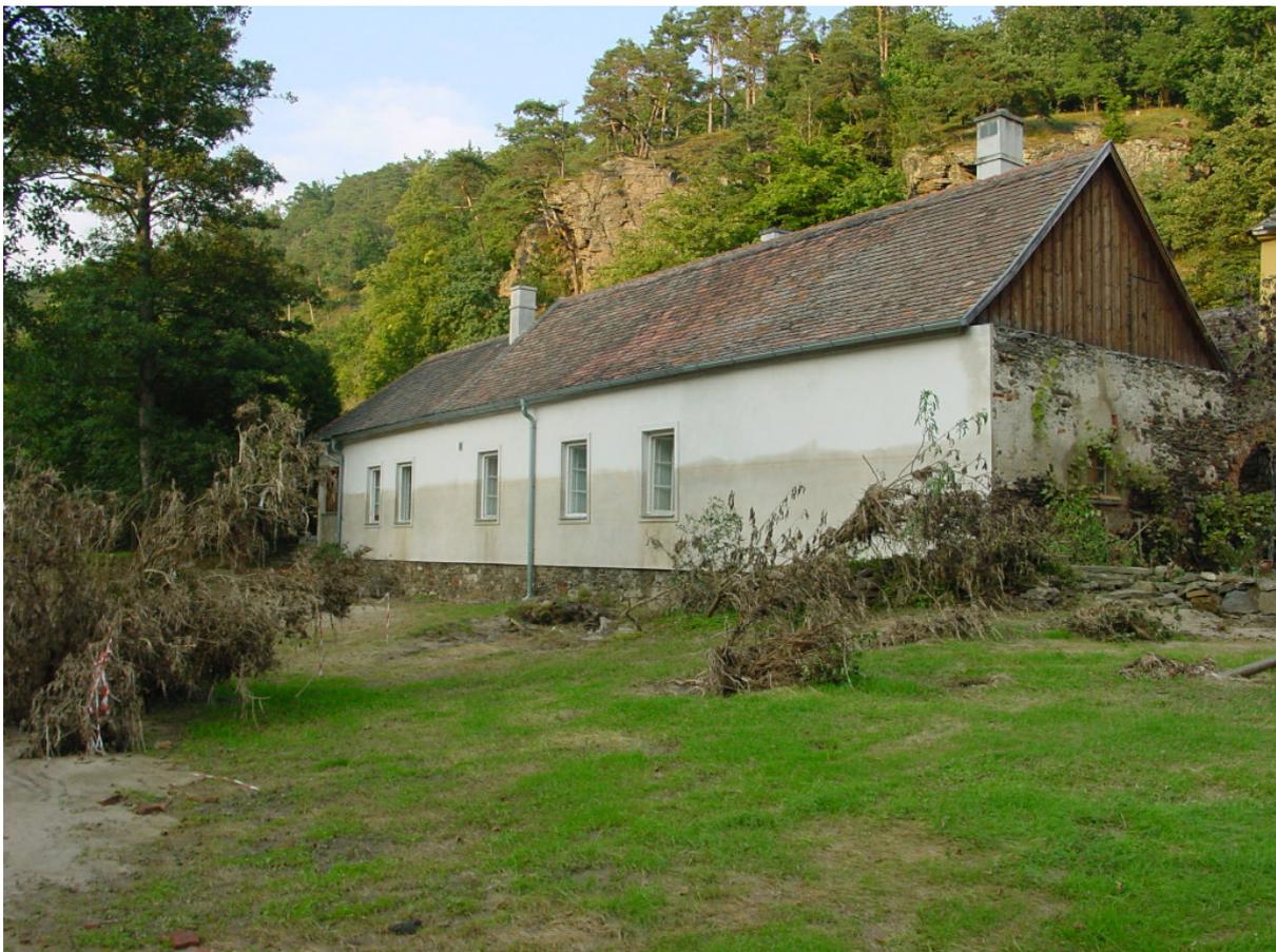
**Abb. 3.2** Spuren des Hochwassers im August 2002 in der Nähe von Rosenberg am Kamp (Strecke Nr. 5). Die Abflussspitze betrug ungefähr 570 m<sup>3</sup>/s. Foto: Pfarre Horn.
