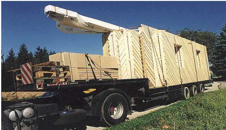
Alternativ können auch geschoßhohe Wandtafeln, die schon im Werk bzw. der Zimmerei mit Strohballen bestückt werden, auf die Baustelle transportiert und aufgestellt werden (Abb. 8-5), was die Bauzeit erheblich verkürzt. Die Wände werden außen mit Kalk oder und innen mit Lehm verputzt.
