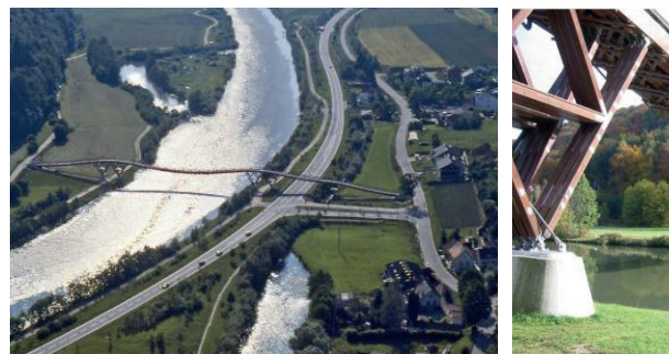
02.24 Brücke in der Landschaft 02.25 Tragwerk
