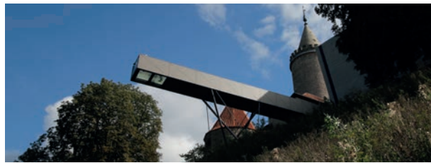
02.55 Ansicht Auskragung von unten
