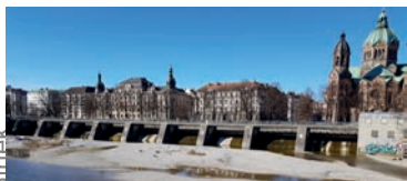
01.26 Wehr IV - Wehrsteg
