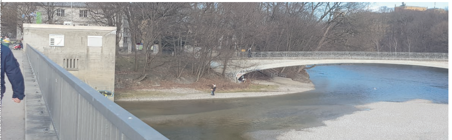
02.54 Blick auf Kabelsteg und Technikraum
