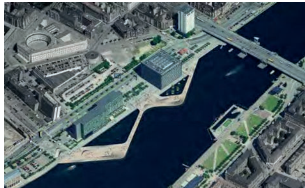
02.42 Stege Kalvebod Wave
