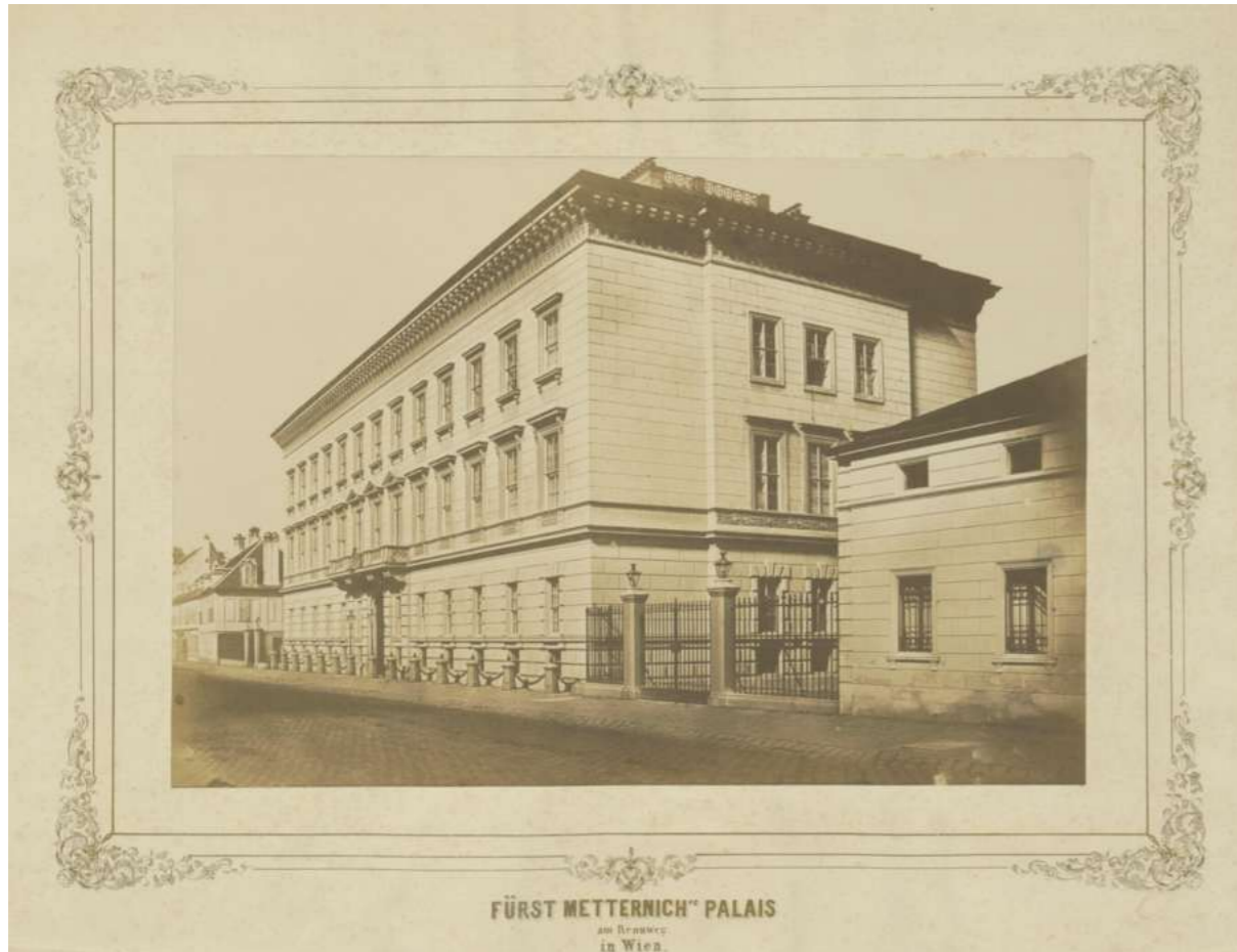
3/5 Das Winterpalais von Fürst Clemens Metternich um 1850, die Botschaft Italiens befindet sich seit 1908 in diesem Gebäude
