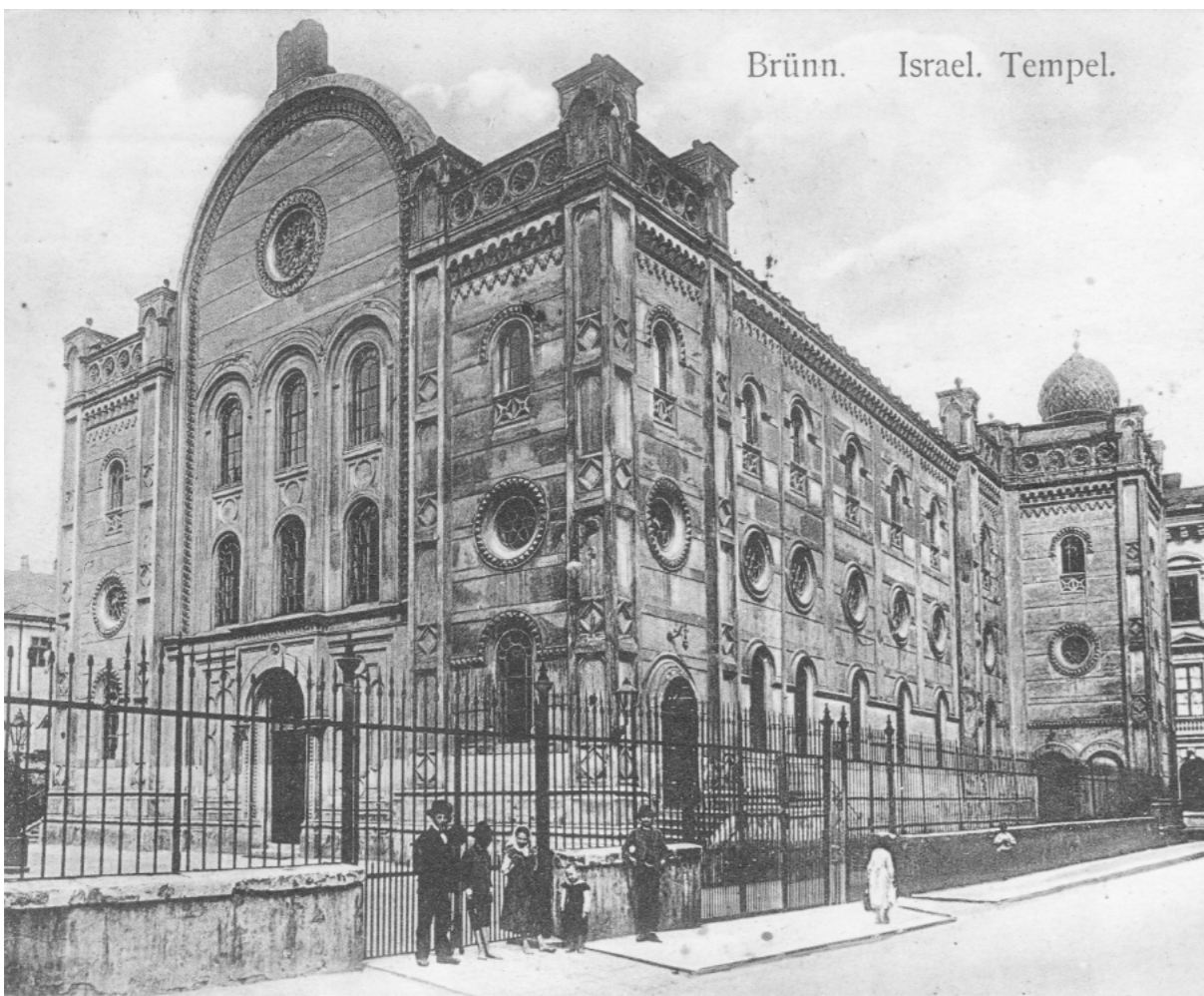
3/21 Postkartenansicht der Großen Synagoge nach der Erweiterung von Ludwig Tischler Ende des 19. Jahrhunderts (Bauphase 2)
