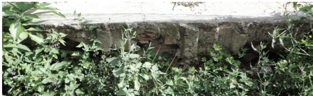
Abb. B zeigt einen Ausschnitt der östlichen Grundgrenze, Teile des Fundaments der zerstörten Synagoge sind auf dem nach wie vor unverbauten Grundstück sichtbar (Stand Jänner 2023).
