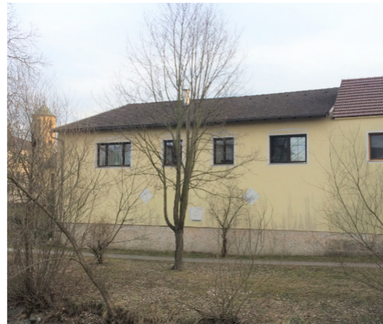
Abb. 4-22: Fotografie der Nordansicht heute (2018)
