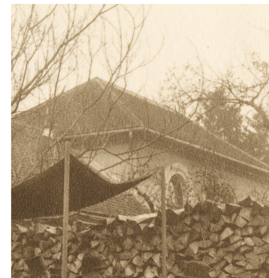
Abb. 4-31: Fotografie des Walmdaches (1929) [kas]
