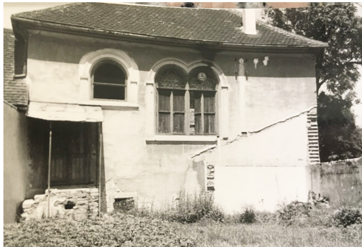
Abb.3-7: Fotografie der Südfassade der Synagoge in Erlach (um 1960) [kas]
