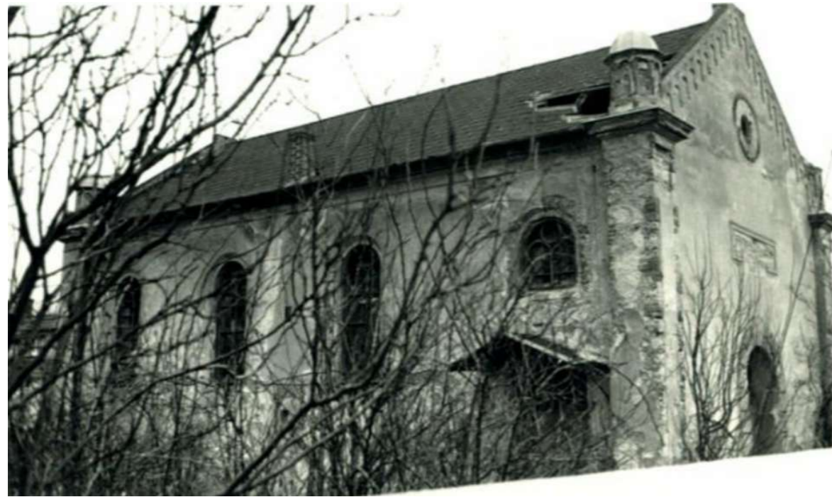
Abb.3-6: Fotografie der Nord/Ost-Fassade der Synagoge in Kobersdorf (1976) [bda]
