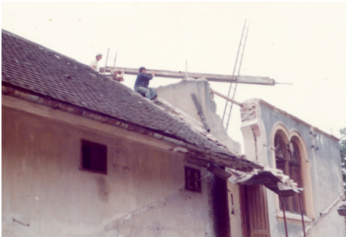
Abb. 4-8: Fotografie der Abbrucharbeiten der Synagoge, Fragmente der Südfassade (1974) [asp]
