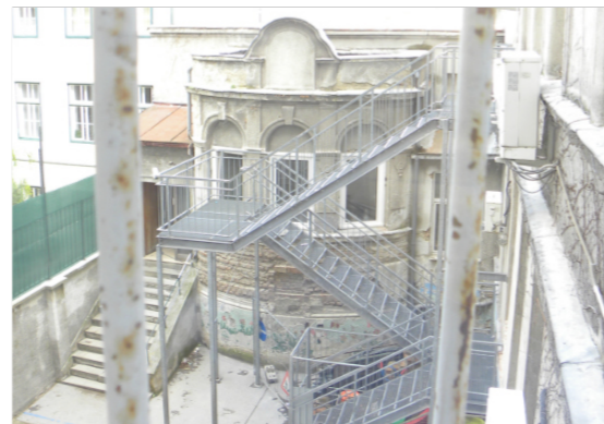
Abb. 11-27: Fotografie Fassade Synagoge (2019)
