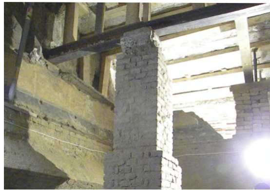
Abb. 11-66: Fotografie Säulengrundament (2019)
