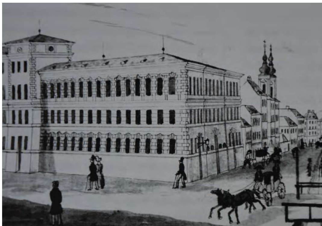
Abb. 02.17: Graues Haus mit Blick auf die Alser Straße
