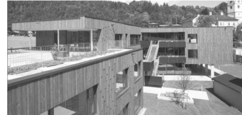
SENIORENWOHNHAUS ST. CYRIAK ABB. 7 WWW.GAT.AT
