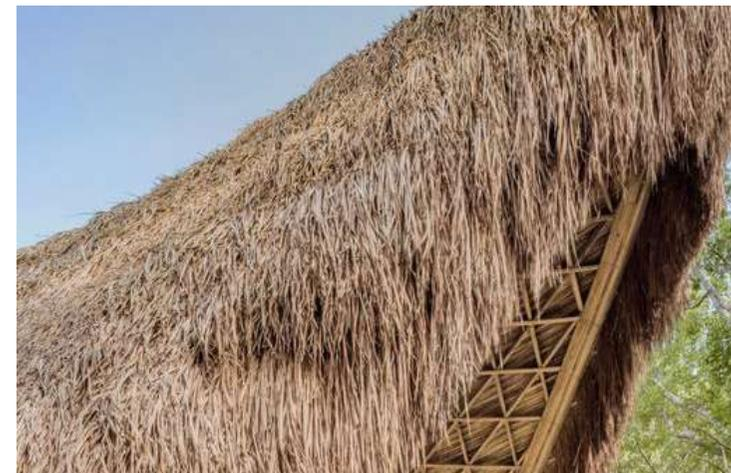
Abb. 18 Dachdeckung mit Grasgewächsen
