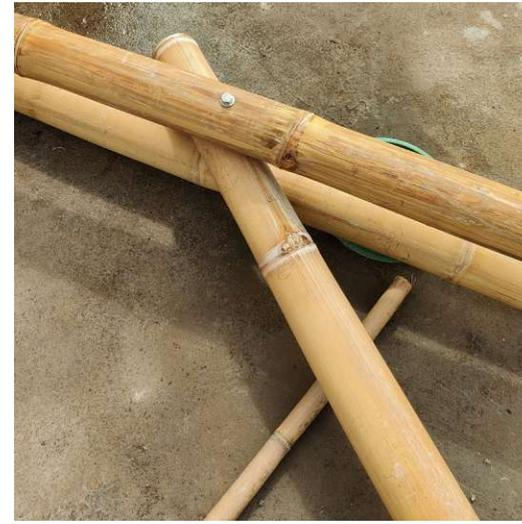
Abb 42 Bambusverbindung
