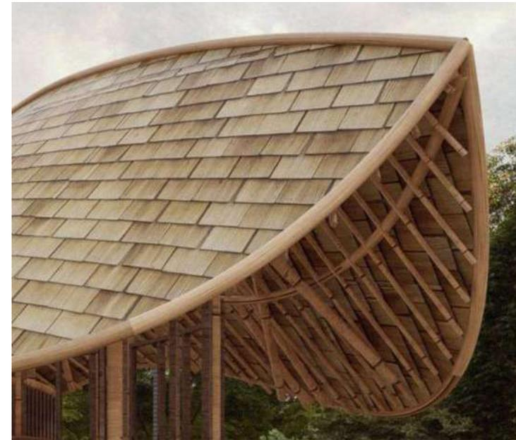
Abb. 17 Dachdeckung mit Schindeln
