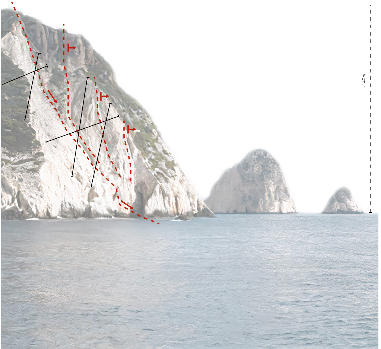
Abbildung 15 | Darstellung der Schwachstellen des Felsens unterhalb des Bauplatzes
