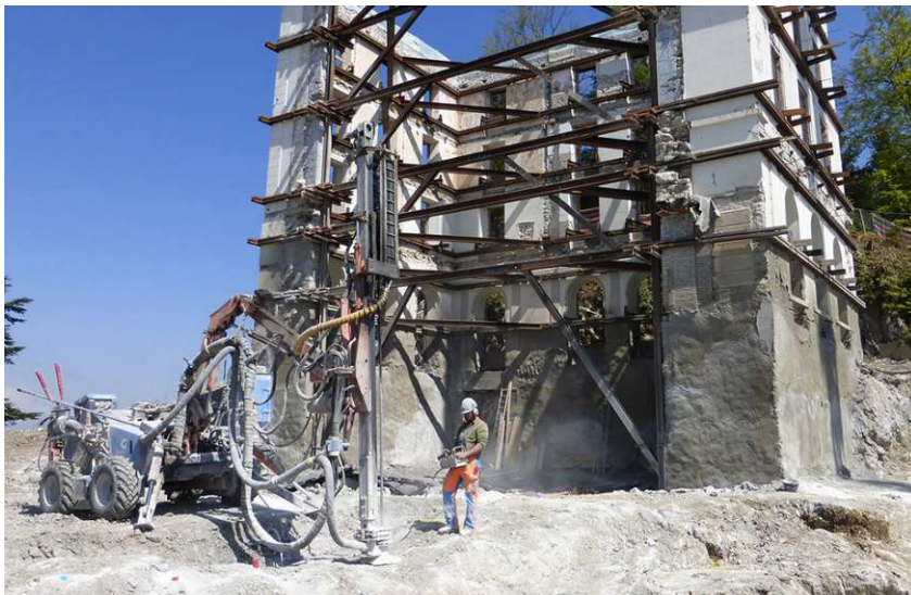
Präzises Sprengen neben einem sensiblen Gebäude
