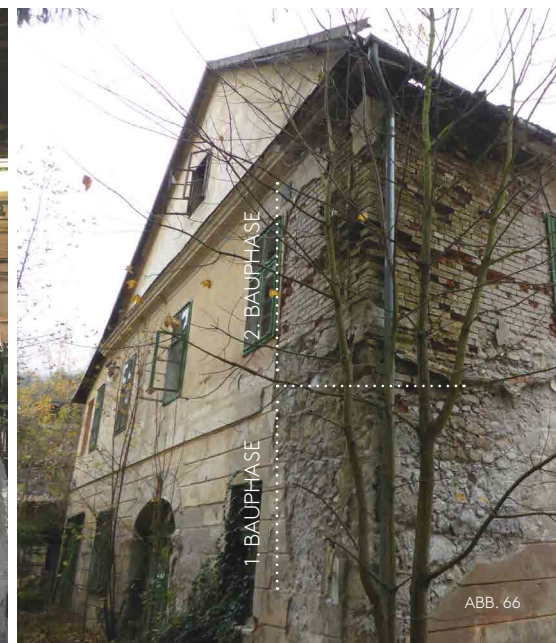
ABB. 65: Kernbau aus Natursteinmauerwerk mit Ziegeln einer Öffnung der 2. Bauphase
