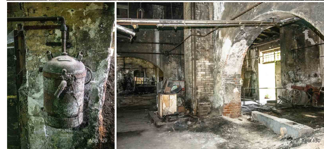
ABB. 128: Blick Richtung Galerie durch Pfeilerarkade ABB. 129: Feuerlöscher ABB. 130: Blick Richtung Eingangstor
