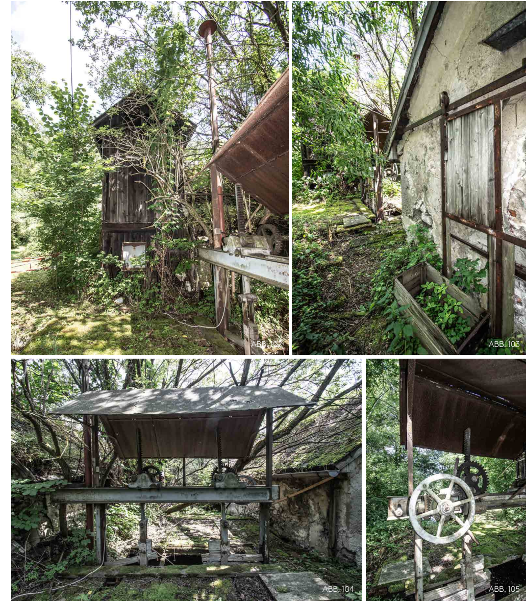
ABB. 102: Ansicht Schuppen mit Wehr ABB. 103: Westfassade, Schiebetür zu Galerie ABB. 104: Ansicht Wehr ABB. 105: Steuerrad Wehr
