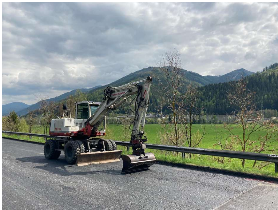
Abb. A.12: Baggerarbeiten zu Reinigung
