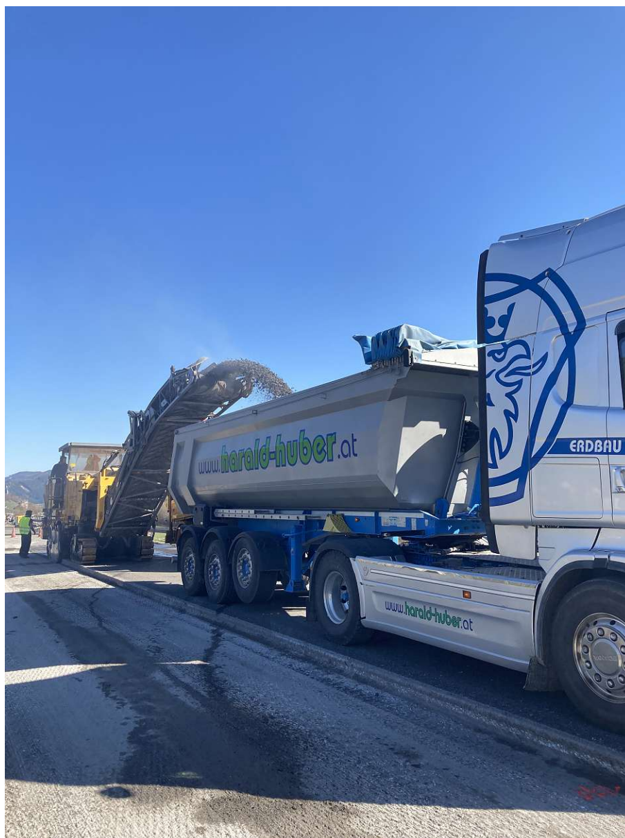
Abb. A.2: Fräse und davor fahrender Lkw
