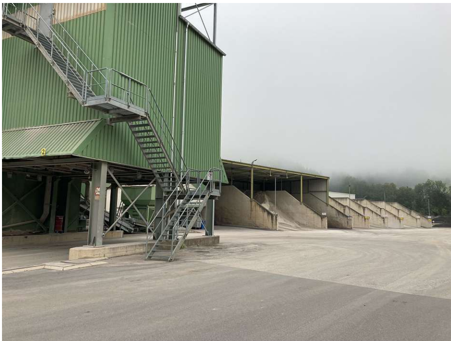
Abb. A.22: Mischanlage Mürzzuschlag (Mischturm und teilüberdachtes Gesteinslager)
