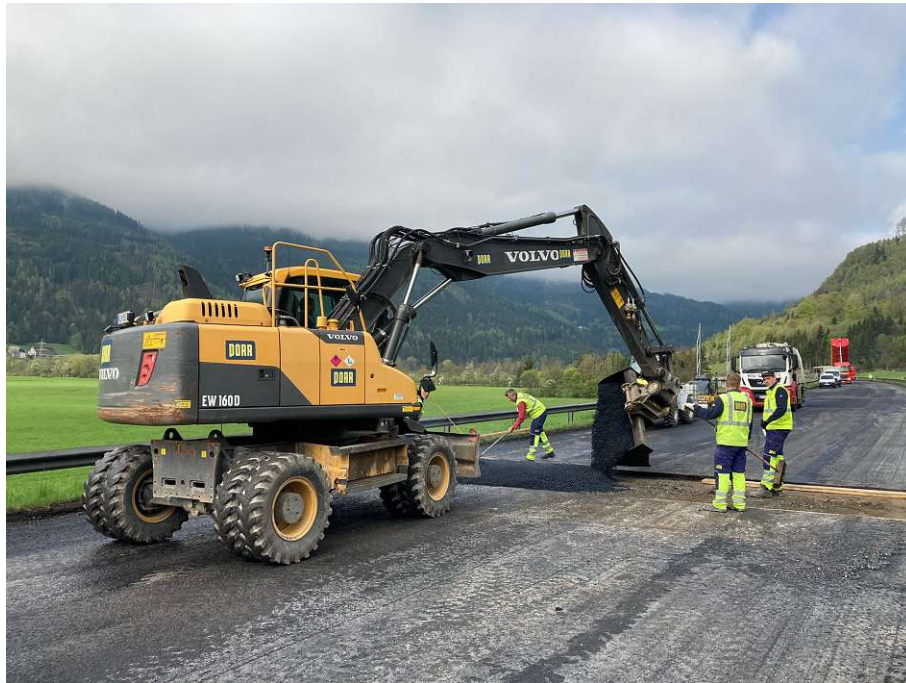
Abb. A.14: Händischer Einbau mit Baggerbeschickung
