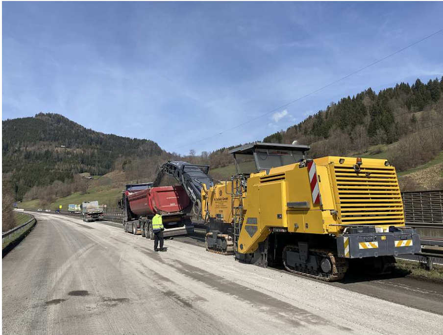
Abb. A.3: Fräse und davor fahrender Lkw
