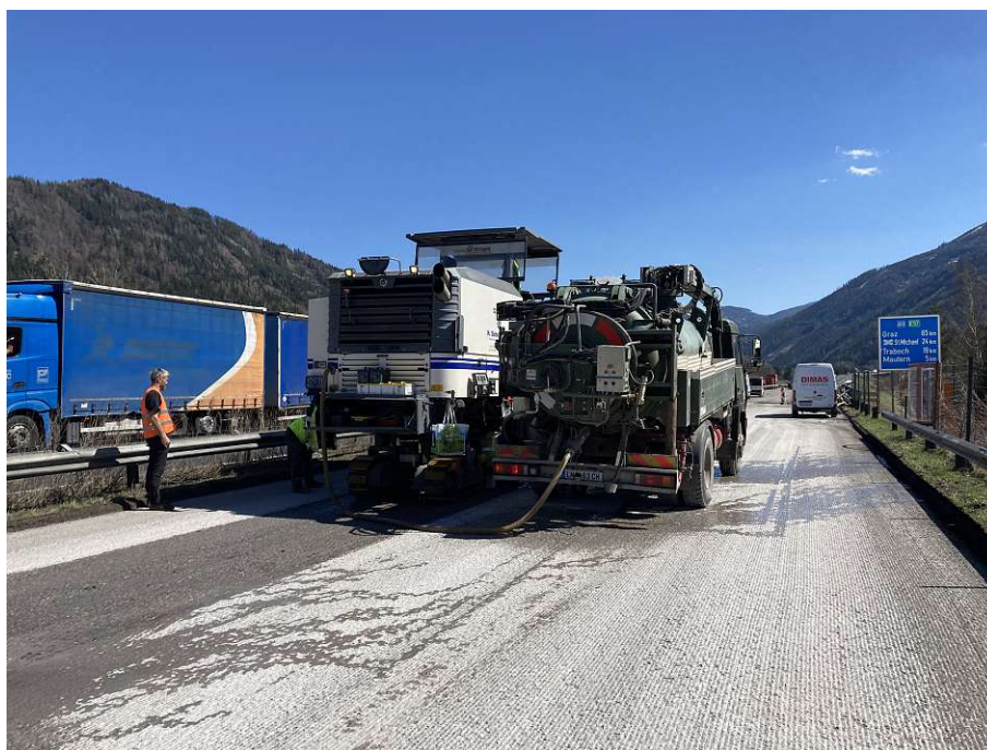
Abb. A.5: Kanalspülwagen während der Wasserzuführung zur Fräse
