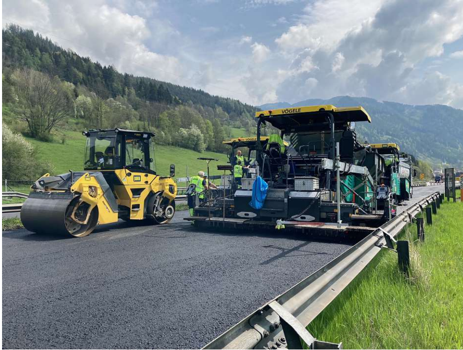
Abb. A.10: Walze und Fertiger in der Ausführung
