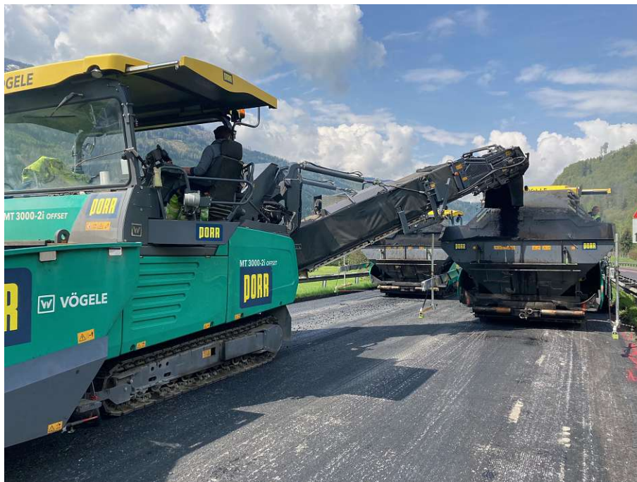
Abb. A.9: Beschicker und Fertiger während des Beschickvorgangs
