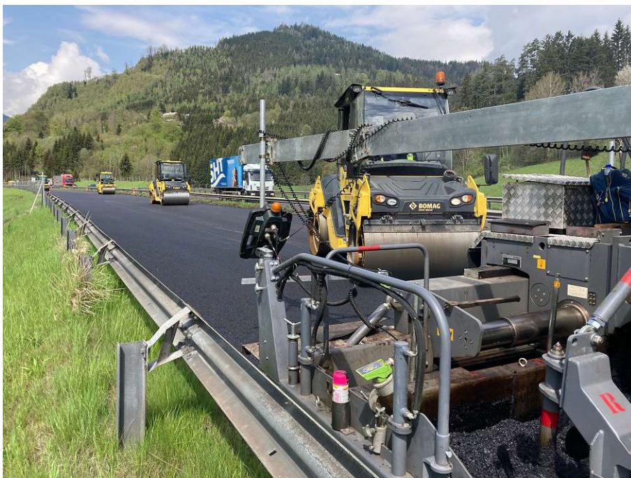
Abb. A.11: Walzen während der Verdichtungsarbeiten
