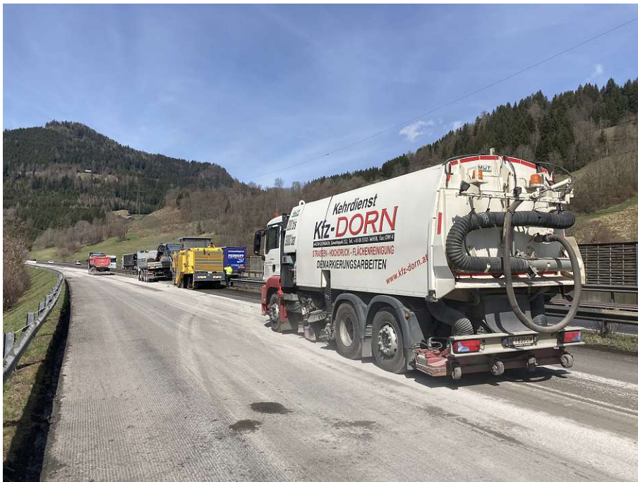
Abb. A.4: Kehrmaschine zur Reinigung der Fräsfläche
