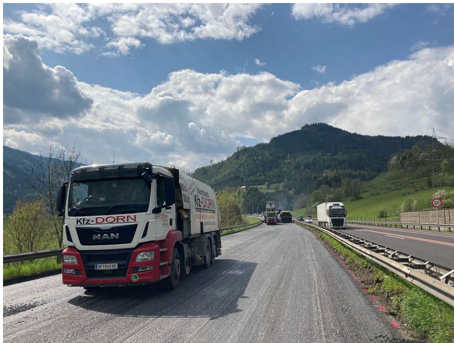
Abb. A.15: Kehrmaschine während Reinigungsarbeiten
