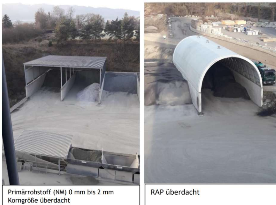
Abb. A.19: Mischanlage Feistritz mit Teilüberdachung
