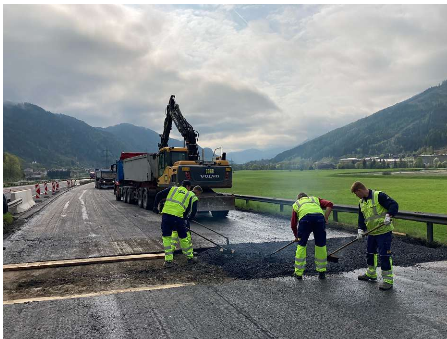
Abb. A.13: Händischer Einbau mit Baggerbeschickung
