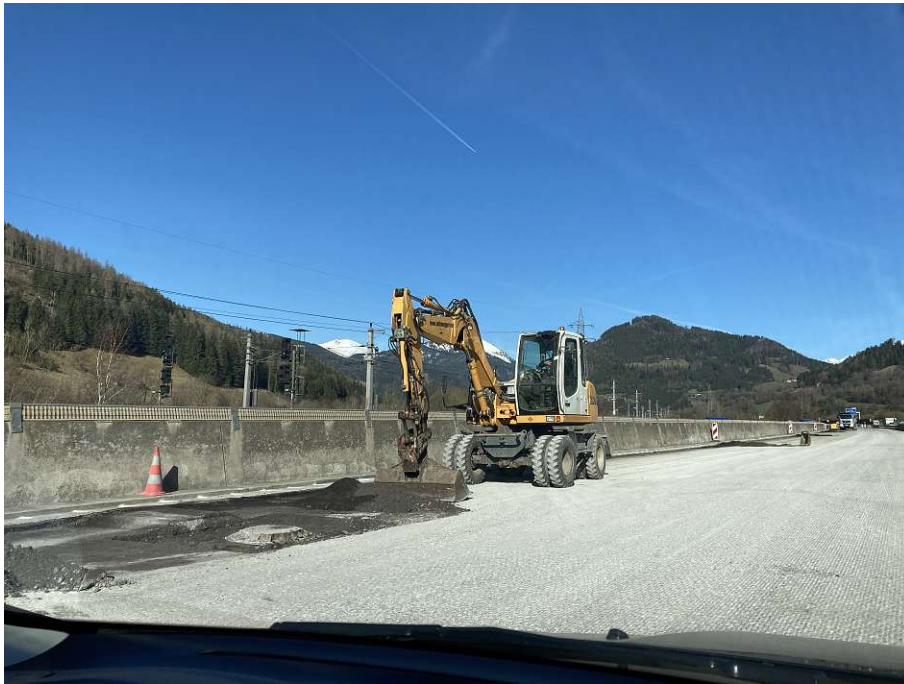
Abb. A.7: Baggerarbeiten zur Reinigung der Fräsfläche
