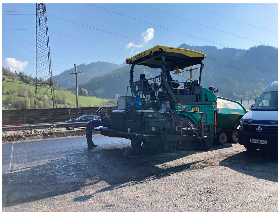
Abb. A.17: Fertigerreparatur
