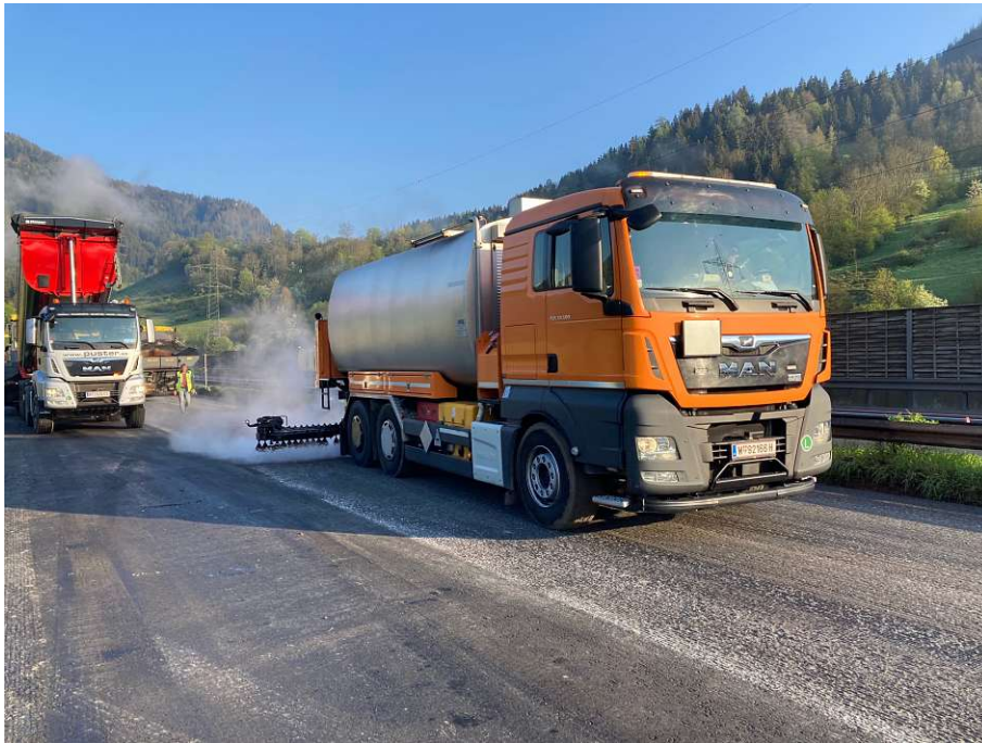
Abb. A.18: Vorspritzwagen während Vorspritzarbeiten
