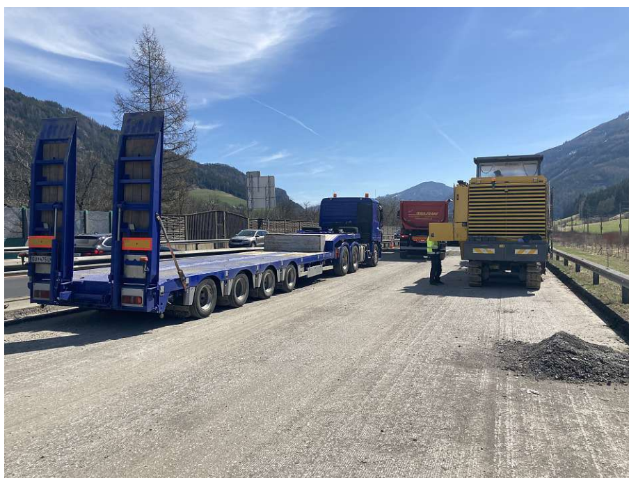
Abb. A.6: Tieflader für den Transport der Fräse
