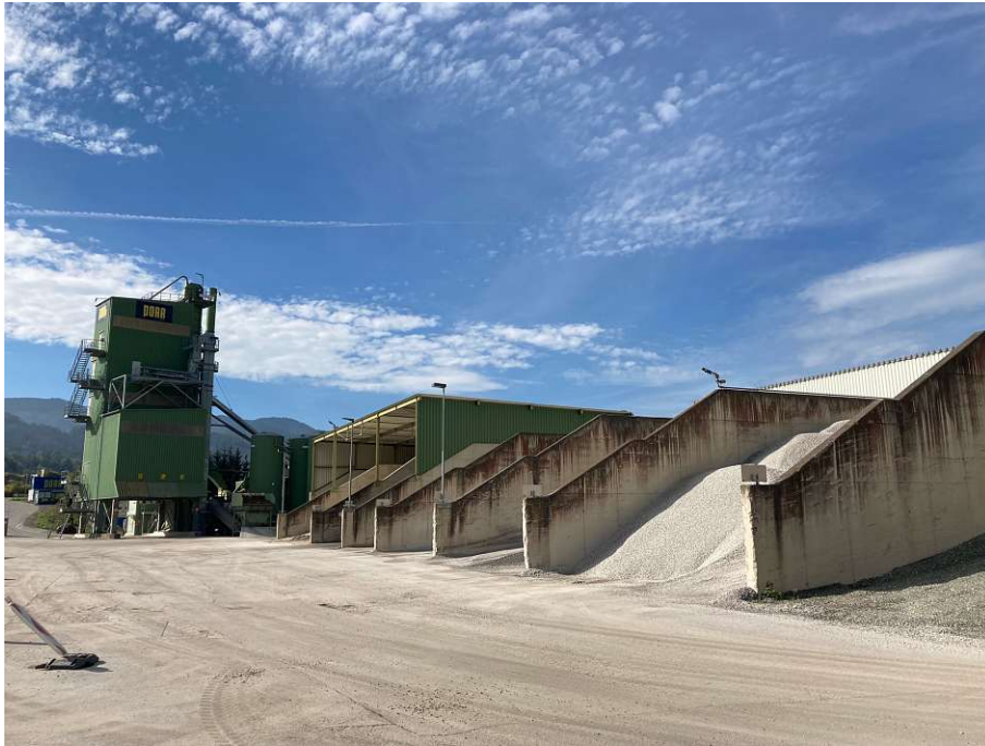
Abb. A.21: Mischanlage Mürzzuschlag (Mischturm und teilüberdachtes Gesteinslager)
