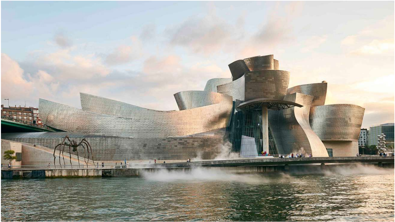
Fig. 70 Guggenheim Bilbao, Frank Gehry
