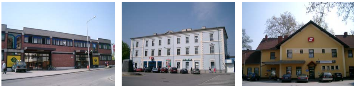
Abbildung 6-4 „Internationaler Bahnhof Sopron“, Bahnhof Wiener Neustadt, Bahnhof Eisenstadt
