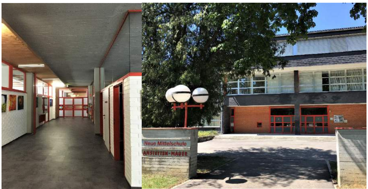
Abbildung 65 Innenraum NMS Mauer, Juli 2019 Abbildung 66 Die Neue Mittelschule Mauer heute, Juli 2019
