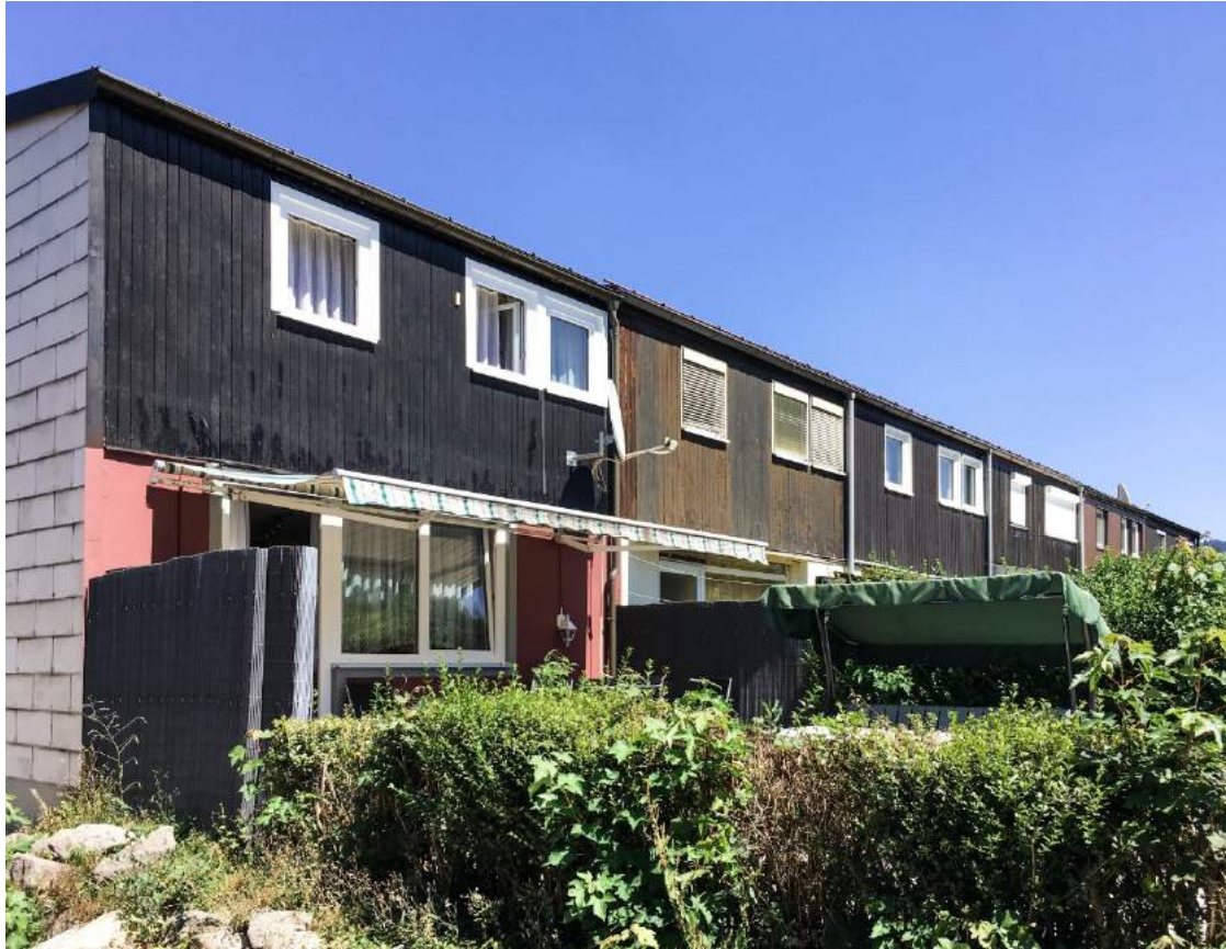
Abbildung 8 Reihenhaussiedlung Böhlerwerk, Juli 2019
