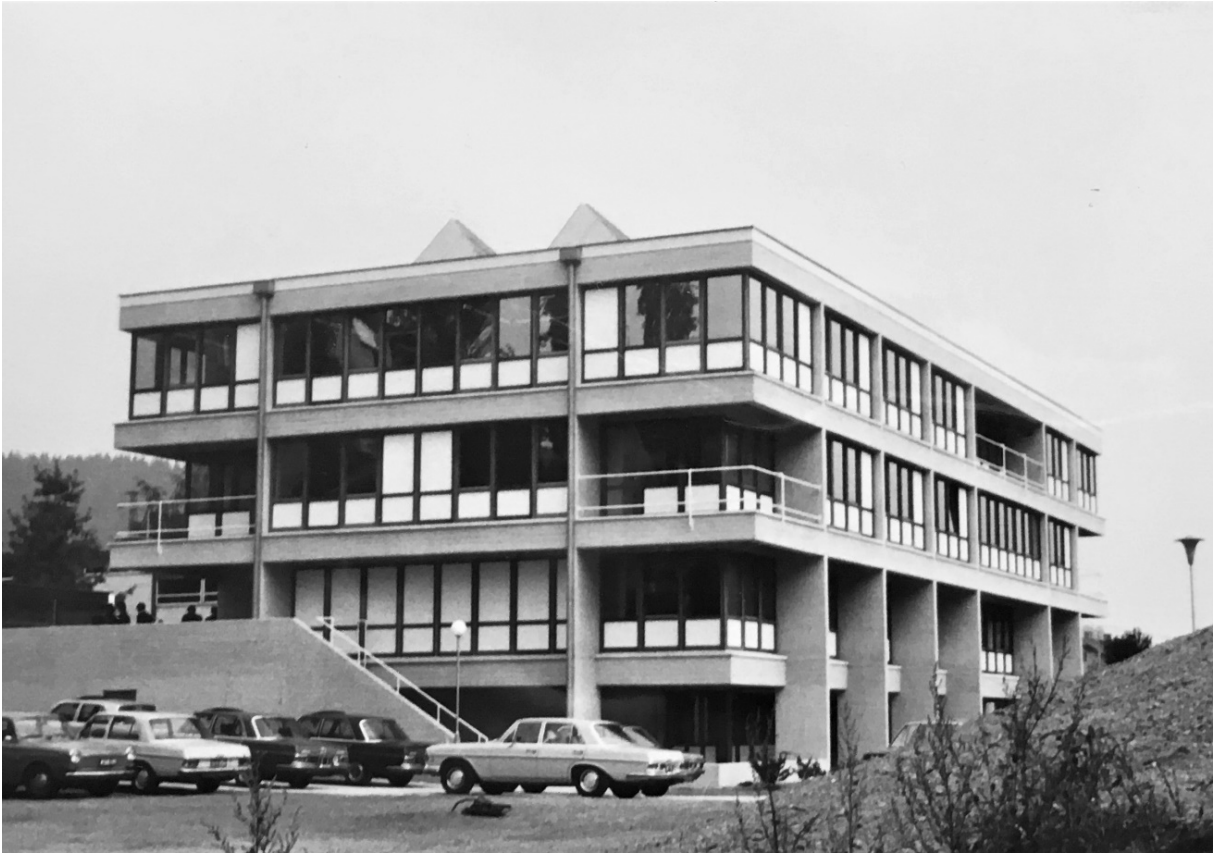
Abbildung 38 Der Erweiterungsbau des Volksheims in Kapfenberg, zeitgenössische Aufnahme
