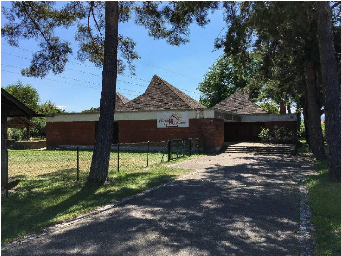
Abbildung 60 Außenansicht heute: Kindergarten Eggersdorf, Juli 2019
