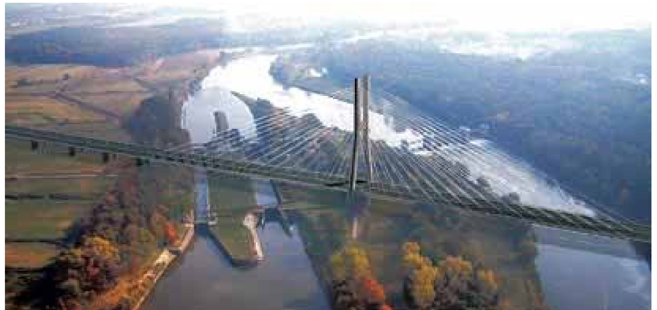
Abb.79 Neue Brücke an der Oder - Autobahn
