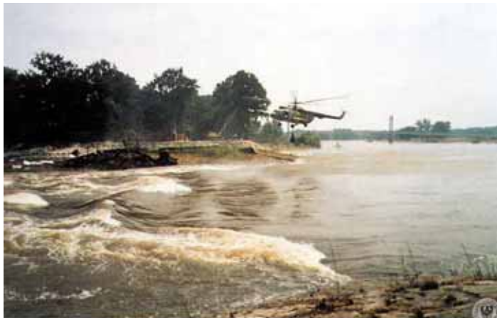
Abb.60 Stauwehr Szczytniki (Scheidnitz) – Befestigung des zerstörten Teiles von der Seite des Tiergartens
