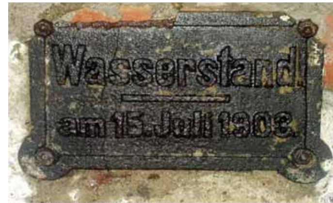
Abb.55 "Wasserstand am 15. Juli 1903" – Diese Tafel befindet sich auf der Höhe von ca. 65m über dem Grundboden. Im Jahre 1997 stieg das Wasser an dieser Stelle um etwa 25m höher.
