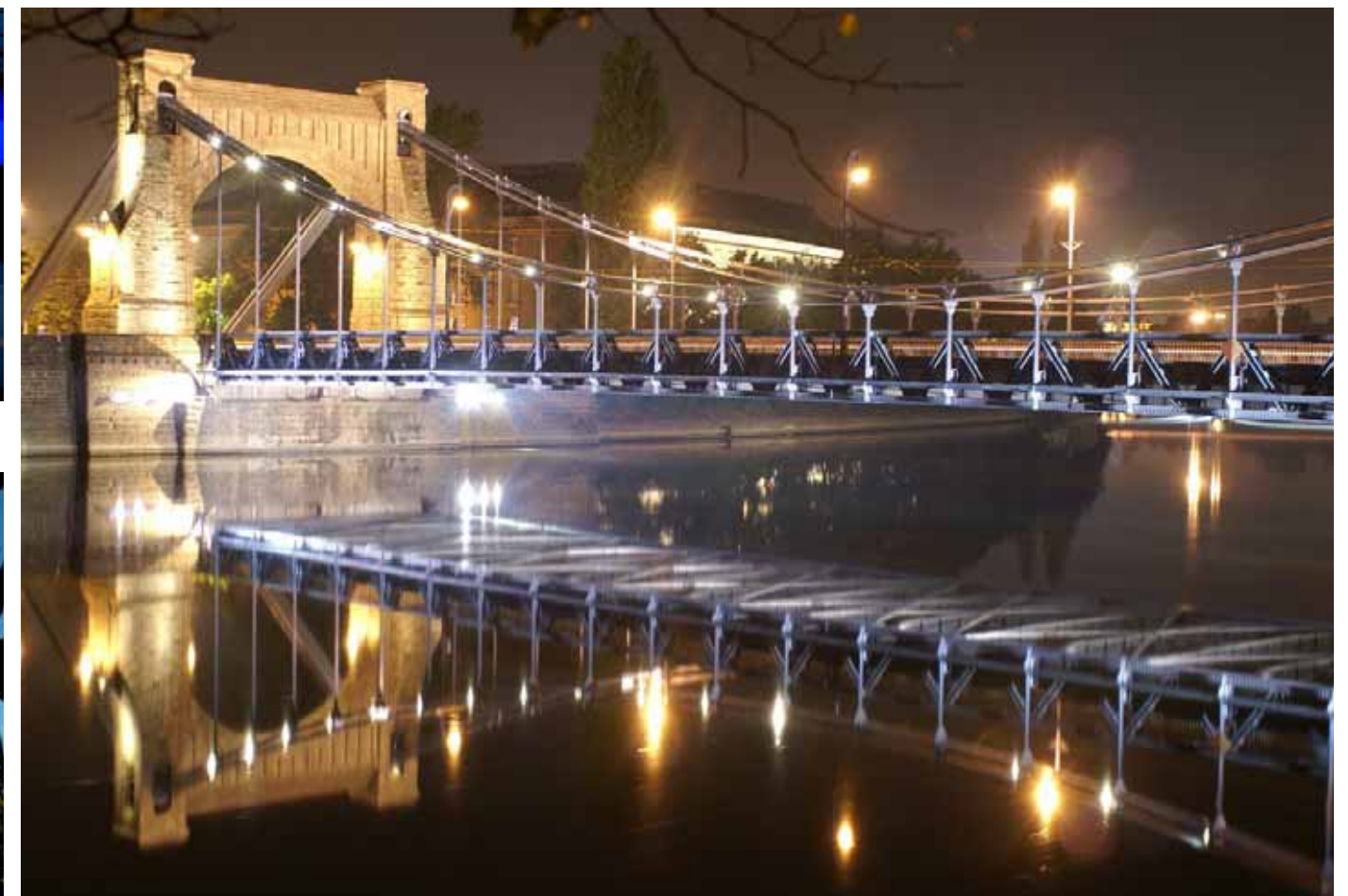
Abb.51 Die "Grunwaldzki" Brücke
