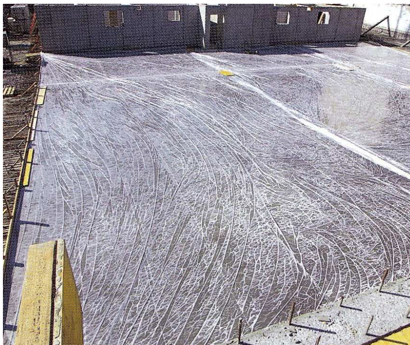
Abbildung 6: Foliennachbehandlung und deren Problembereiche (Quelle: [Hol04] )
