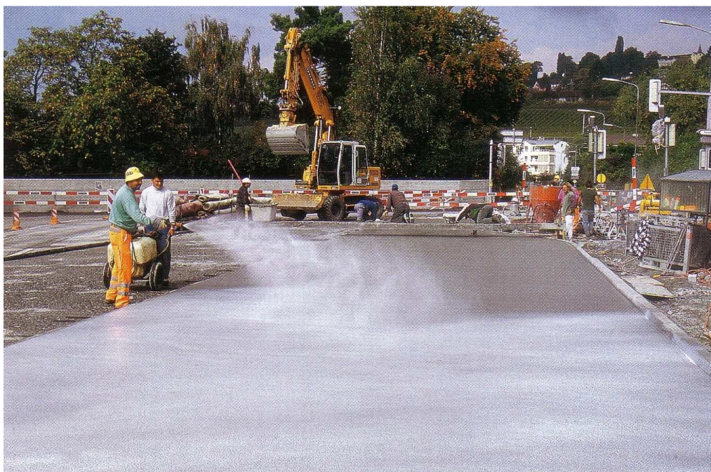
Abbildung 5: Aufspritzen eines flüssigen Nachbehandlungsmittels auf der Baustelle (Quelle: [Hol04] )
