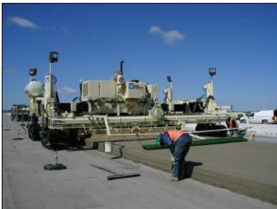
Abbildung 2: Beispiel eines Gleitschalungsfertigers (Quelle: www.hedke.com )
