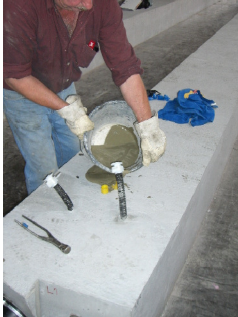
Abbildung 4.6: Verpressen der Hüllrohre
