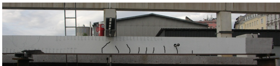
Abbildung 9.19: Gerissene Bereiche im Feld (x=positiv)
