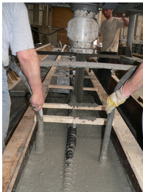
Abbildung 4.3: Betonieren und Verdichten
