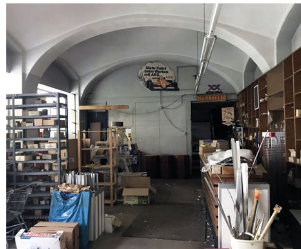
Abb. 19 Schießstattgasse 2, Gewölbe Hoftrakt
