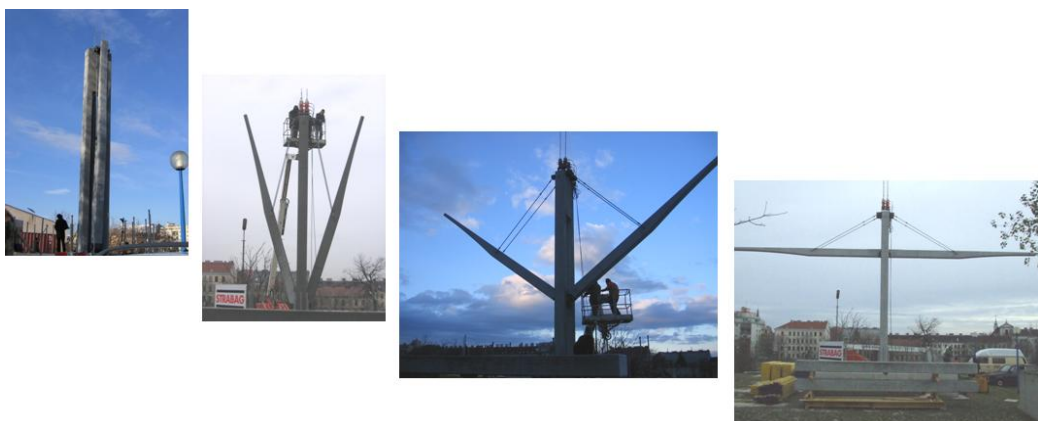
Abb. 106 Bilderabfolge: Druck- und Zugvorgang beim Brückenklappverfahren (TU-WIEN, 2007)
