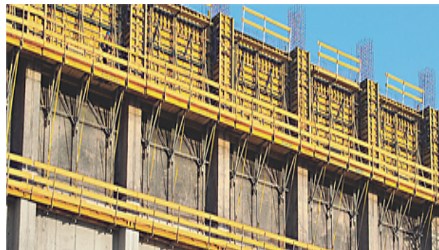
Abb. 77 Kletterschalung MF 240 (DOKA GmbH, 2008)
