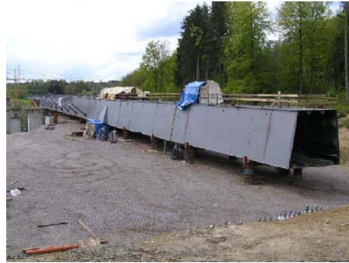
Abb. 148 Taktschiebeanlage
