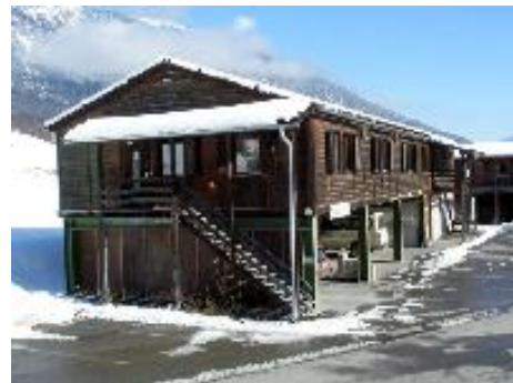
Abb. 51 Baubaracke (TIEFBAUAMT GRAUBÜNDEN, 2007)
