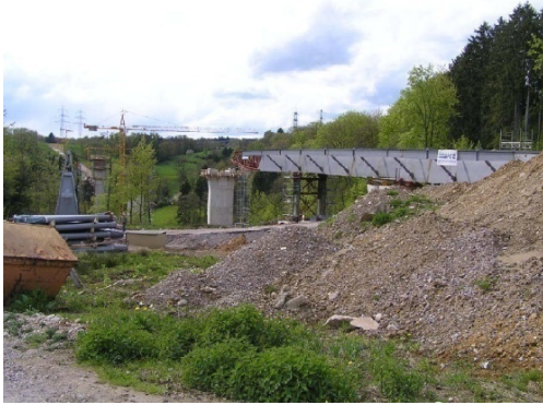
Abb. 147 Taktschiebeverfahren 1. Stützenfeld
