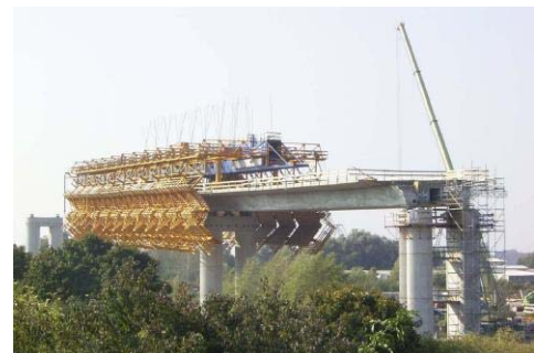
Abb. 7 Vorschubrüstung - Schalungsgerüst geklappt
