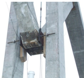
Wälzgelenke (Druckstreben rollen am Fußpunkt aneinander ab)
