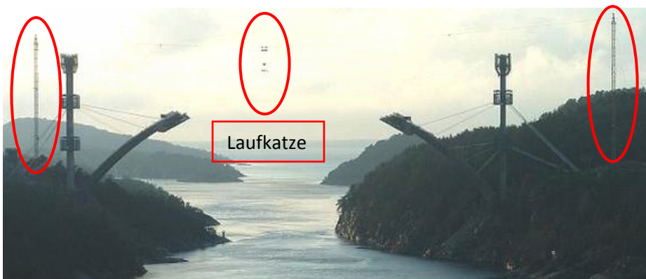
Abb. 43 Kabelkran (SKAILAND Kranservice, 2008)
