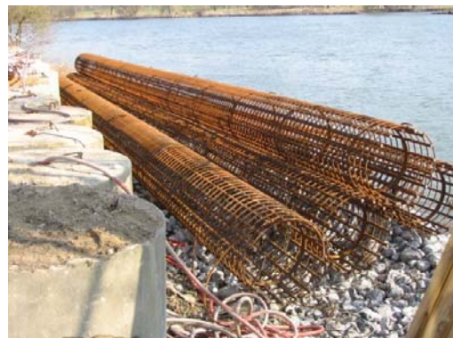
Abb. 48 Bewehrungskorb Großbohrpfahl
