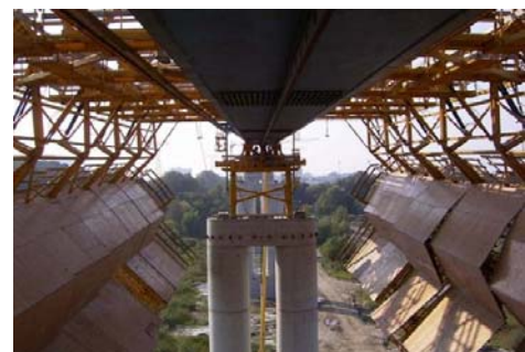
Abb. 8 Vorschubrüstung - Innenansicht des Schalungsgerüsts
