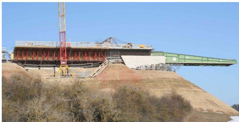
Abb. 49 Vorfertigungs- und Vorschubanlage für das Taktschiebeverfahren in Spannbeton (STÖRFIX, 2006)
