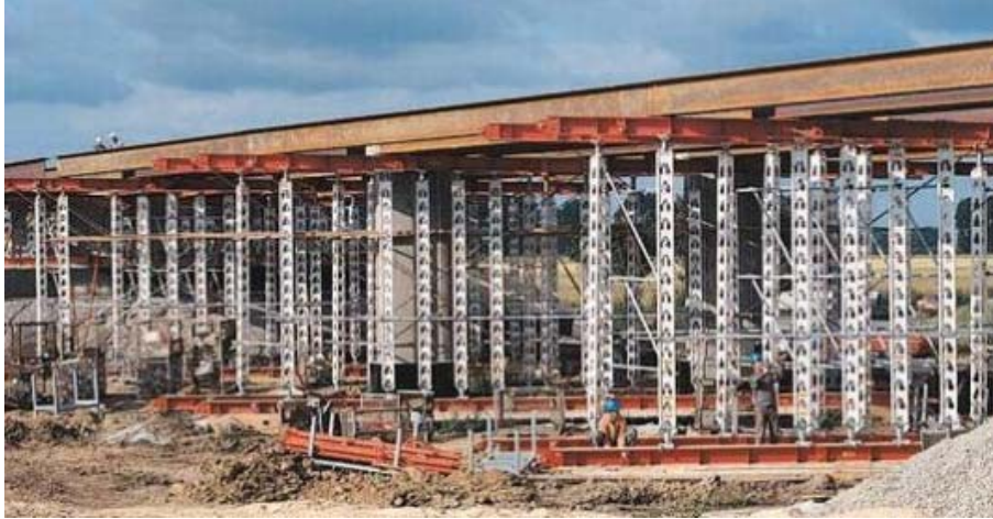
Abb. 70 Traggerüst (OELLINGRATH, 2008)
