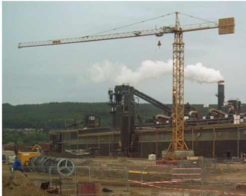
Abb. 41 Turmdrehkran - Obendreher
