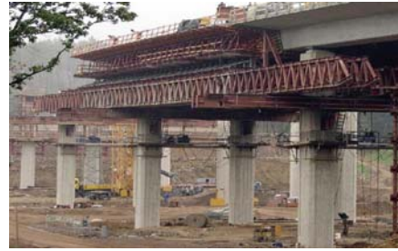
Abb. 9 Untenliegende Vorschubrüstung (THYSSENKRUPP, 2008)
