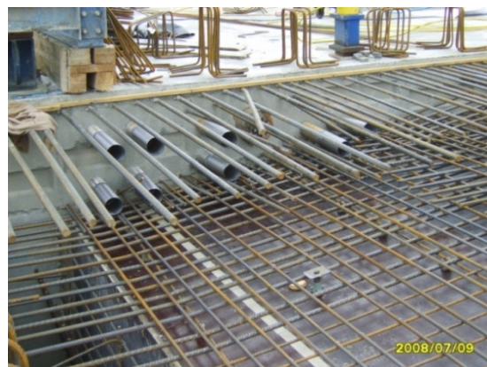
Abb. 95 Hüllrohre verlegt
