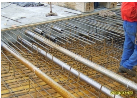
Abb. 95 Hüllrohre verlegt
