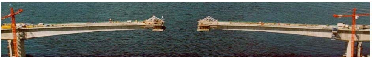
Abb. 16 Skye Bridge (DYWIDAG, 2005)
