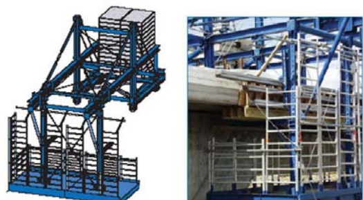
Abb. 72 Gesimskappen - Schalwagen (ROBUSTA-GAUKEL, 2008)
