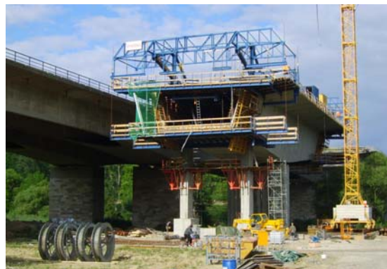
Abb. 18 Herstellung des Überbaus im Freivorbauverfahren
