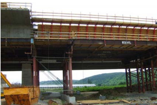
Abb. 17 Herstellung des Überbaus in Lehrgerüstbauweise
