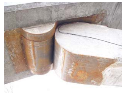
Wälzgelenke (Detailpunkt, wo die Druckstrebe am Brückenträger abrollt)
