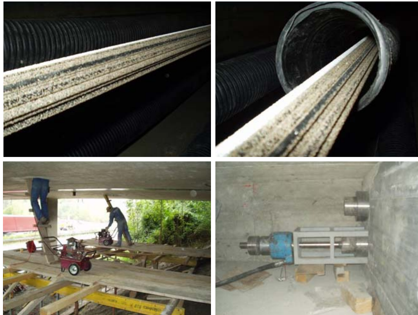
Abbildung 8.14: Oben: Drehen am Ankerkörper vor dem eigentlichen Spannvorgang \Rightarrow parallele Ausrichtung der einzelnen CFK-Drahte des CFK-Spanngliedes; gut ersichtlich durch den eingefarbter CFK-Draht (torsionsfreier Einbau des Spanngliedes); links unten: Arbeitsbuhne mit Hydraulikaggregat; rechts unten: Spannvorgang mit Spannstuhl, Spannspindel, Hydraulikpresse und Spannmutter
