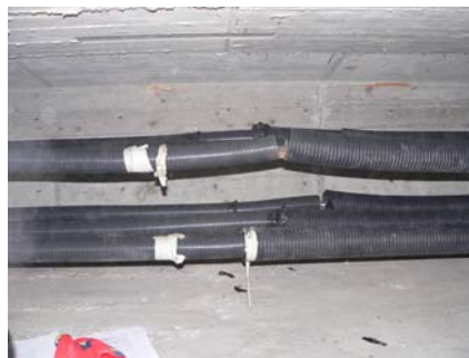
Abbildung 8.21: Hüllrohre auf freier Spannliedlänge (Hohlkasten Villach) linkes Hüllrohr = fixiert am Ankerkörper; rechtes Hüllrohr = beweglich
