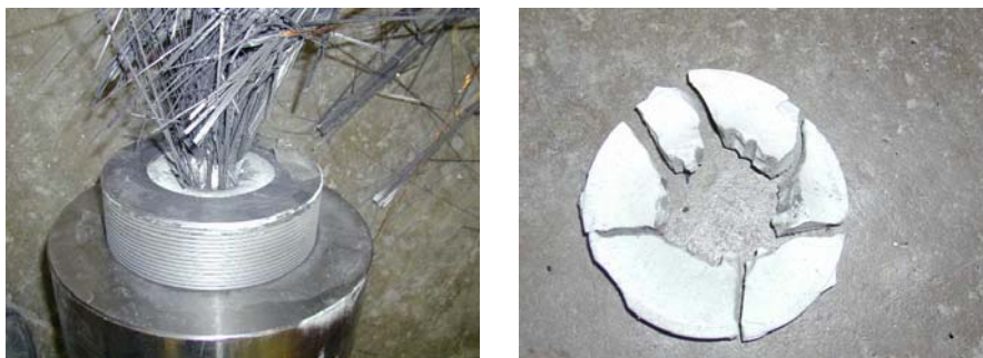
Abbildung 6.10: Verankerungskörper 19 II F 1 nach dem Zugversuch: links - lastnahes Verankerungsende; rechts - abgebrochener lastnaher Epoxidharzüberguss
