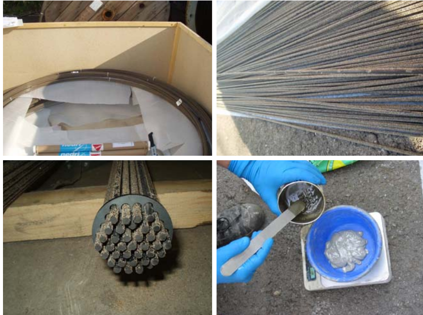
Abbildung 8.4: Lieferung der CFK-Drähte, erstes Ablängen der CFK-Drähte, Fixierung der ersten Seite des hexagonalen CFK-Zugelements
