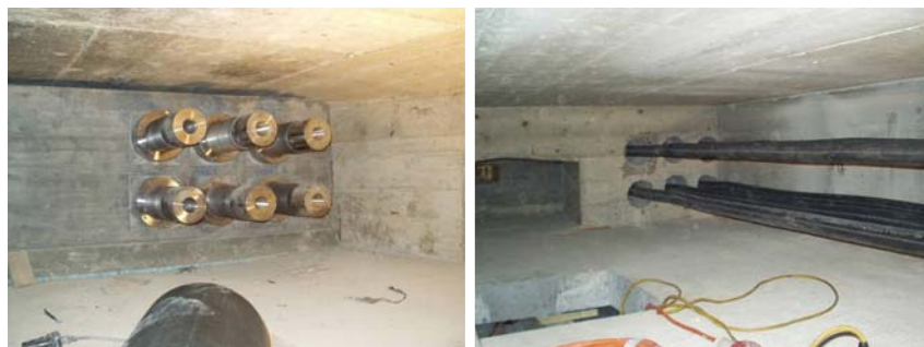
Abbildung 8.15: CFK-Spannglieder nach erfolgtem Spannvorgang - links: Ankerkorper; rechts: Hullrohre
