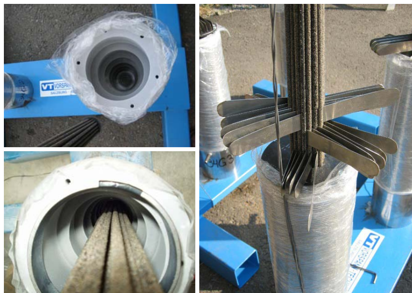
Abbildung 8.6: Lagefixierung des CFK-Zuglements im einteflonisierten Ankerkörper
