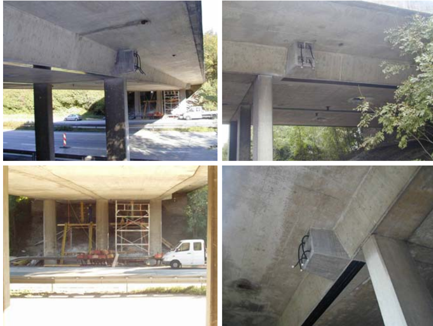
Abbildung 8.3: Vorspannung der neu eingezogenen Querträger, aufgeklebte CFK-Lamellen im Randfeld
