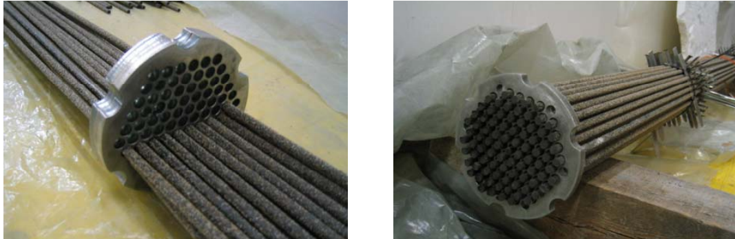
Abbildung 5.11: Links: Fädeln der CFK-Drähte; rechts: Erste Fixierscheibe am ausgerichteten Ende des CFK-Zugelementes
