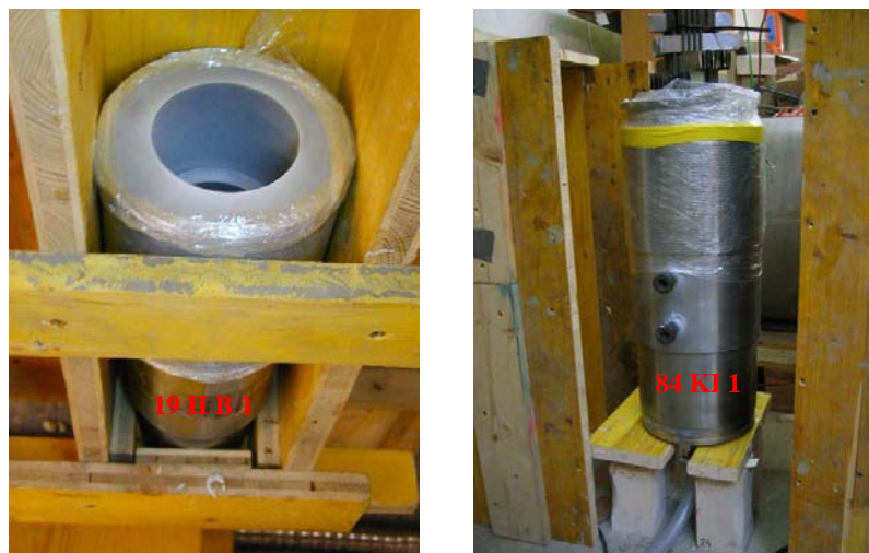
Abbildung 5.10: Schalung und zusammengesetzte Verankerungskörper
