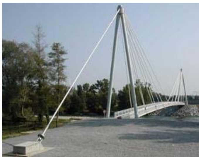
Abbildung 2.16: Laroin Fußgängerbrücke (Frankreich) [htt08]
