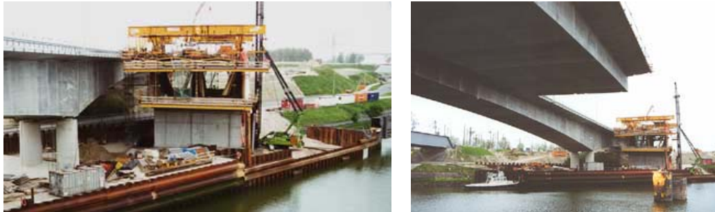
Abbildung 2.13: Dintelhavenbrücke, Rotterdam (Niederlande), Herstellung der Brücken nach der Freivorbaumethode [Cse04]
