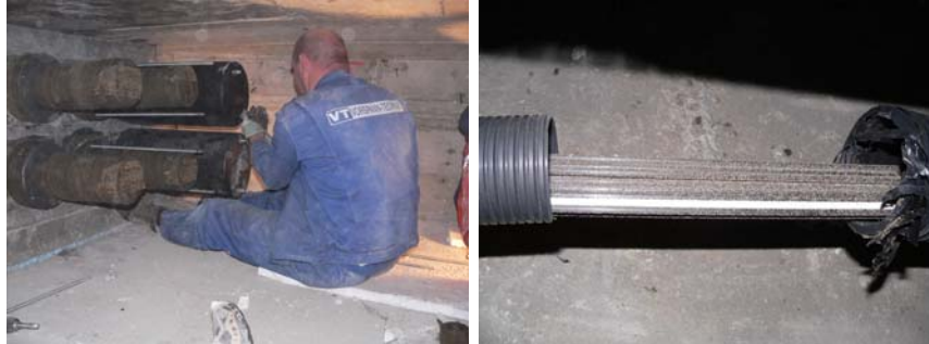
Abbildung 8.20: Links: Wiederherstellen des Korrosionsschutzes ; rechts:CFK-Drähte auf freier Spannliedlänge (Hohlkasten Villach)
