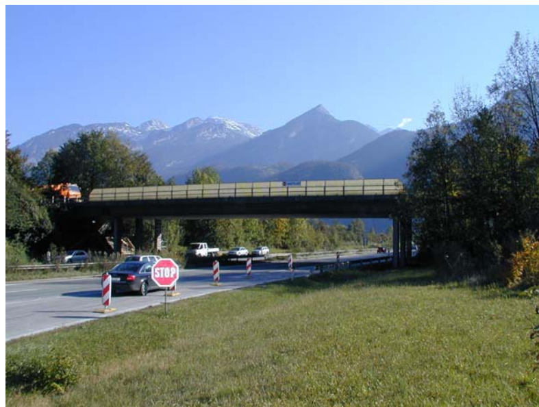
Abbildung 8.1: Gesamtansicht der Autobahnüberführung Golling
