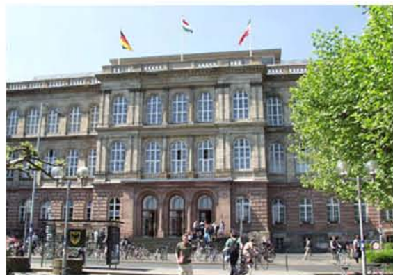
Abb. 100 Hauptgebäude im Zentrum von Aachen
