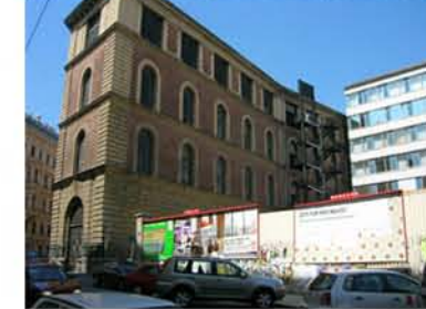
Semperdepot, denkmalgeschützt Sanierung durch Carl Pruscha 1993
