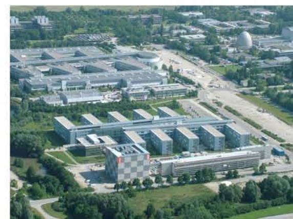
Abb. 112 Luftaufnahme Campus Garching
