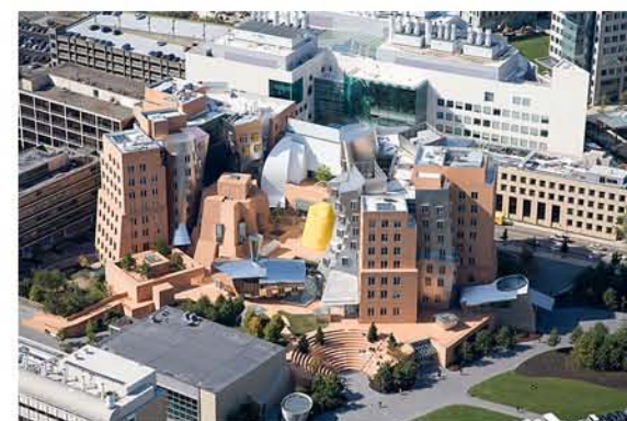
Abb. 96 Stata Center von Gehry an gleicher Stelle
