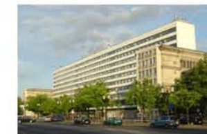
Abb. 108 Hauptgebäude mit Aufstockung nach 2. Weltkrieg
