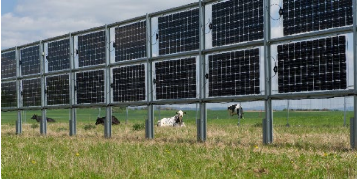
Abbildung 41: Senkrechte installierte Anlagen, (Internationales Wirtschaftsforum Regenerative Energien (IWR), 2018)
