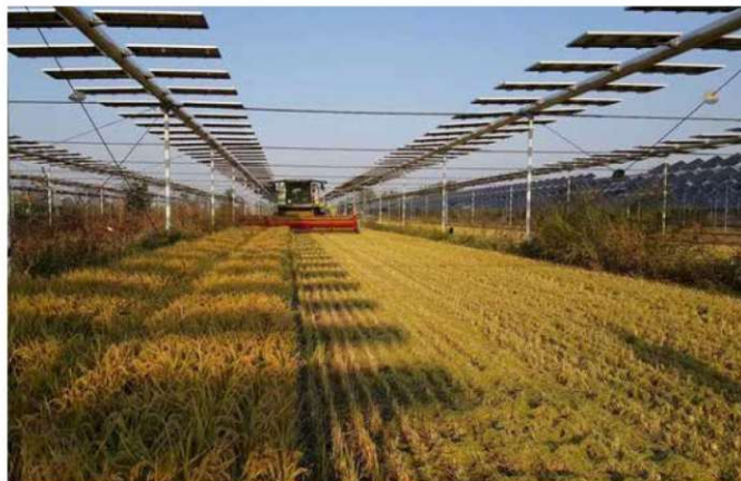
Abbildung 45 Hoch aufgeständerte Anlagen, (Fraunhofer-Institut für Solare Energiesysteme ISE, 2020, S. 29)
