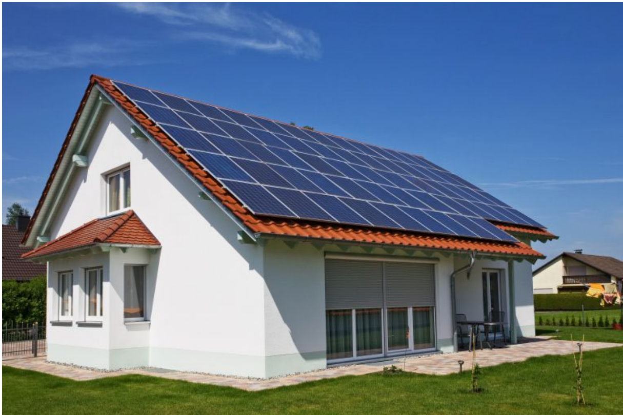
Abbildung 49: PV auf Schrägdach, (Bundesverband Photovoltaic Austria, ohne Datum)
