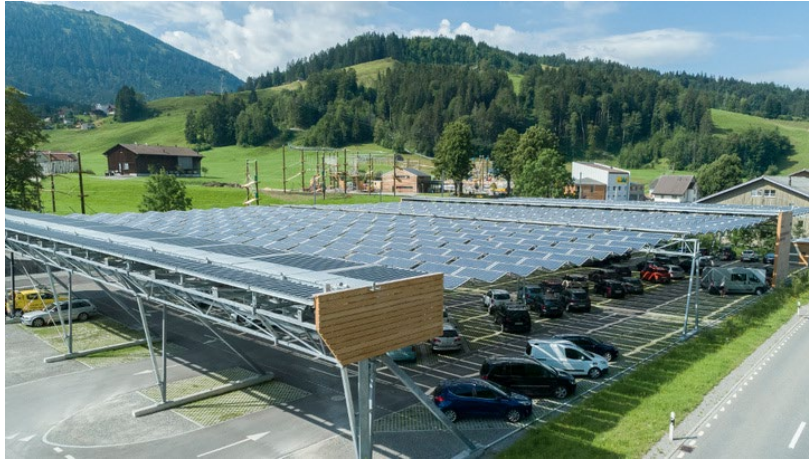
Abbildung 42 PV-Überdachung Parkplatz, (DHP Technology und Alfons W. Gentner Verlag GmbH & Co. KG, 2021)
