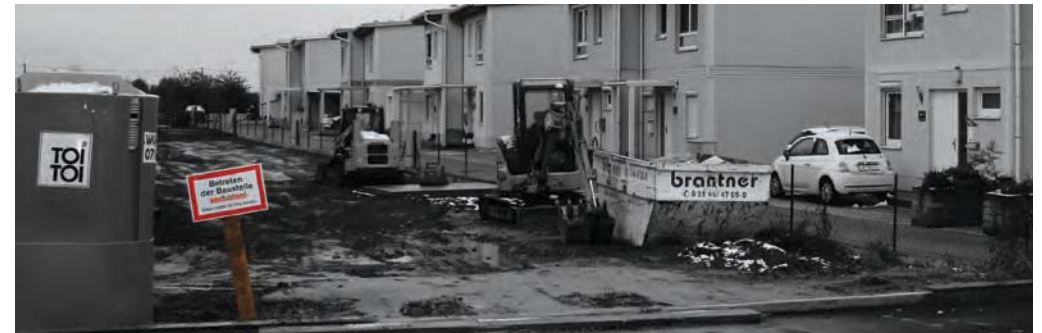
Abb. 20. Baustelle Reihenhäuser, Stammersdorf
