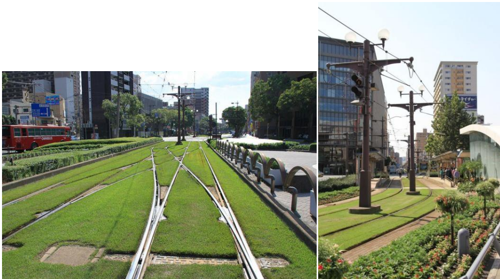
16. Abbildung: Weichen (l) und Haltestellen (r) mit Grünleis – Oberbau in Kagoshima 22
