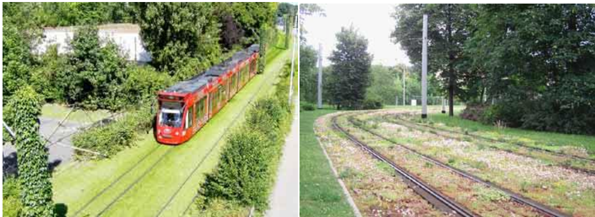
8. Abbildung: (l) Freiburg mit Rasengleis und (r) Zwickau mit Sedumbepflanzung 11
