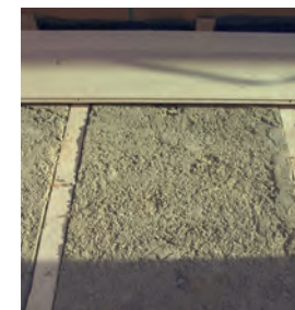
Abb. 188: Lehmestrich zwischen Polsterhölzern
