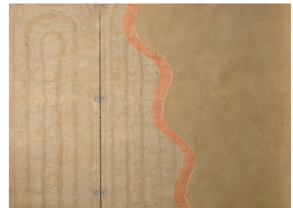
Abb. 124: Rohbauansicht der unputzten Wand mit gewebeüberzogenem Heizregister und aufgebrachtem Lehmputz
