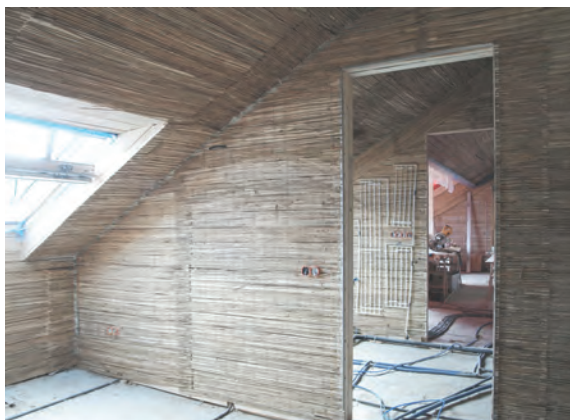
Abb. 114: Schilfarmierung als Untergrund für Lehmputz mit partieller Wandheizung | Andi Breuss |
