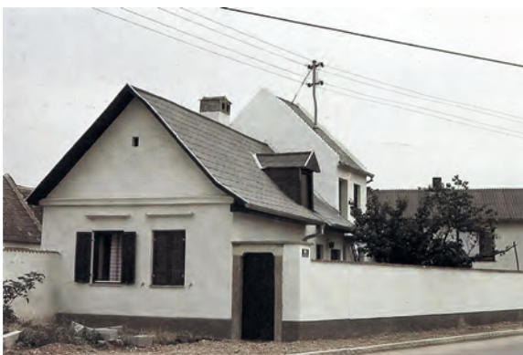
Abb. 45: Vorher | Nachher Vergleich: »Überlieferte Baukultur durch Erneuerung mit Blech und Eternit zerstört« [RAINER, 1990, S. 20]
