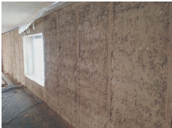
Abb. 113: Lehm auf Strohdämmung | Andi Breuss | 2015
