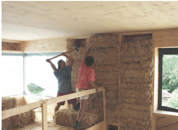
Abb. 112: Einbringen von Strohdämmung in die Außenwand | Andi Breuss | 2015
