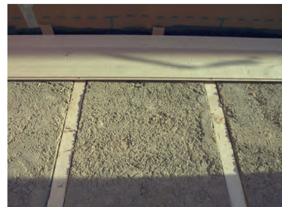
Abb. 115: Lehmestrich zwischen Polsterhölzern | Andi Breuss
