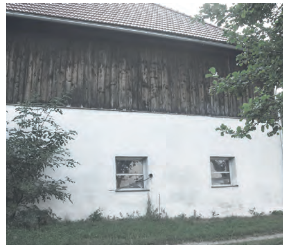
Abb. 97: Kalkputz auf einem Stallgebäude
