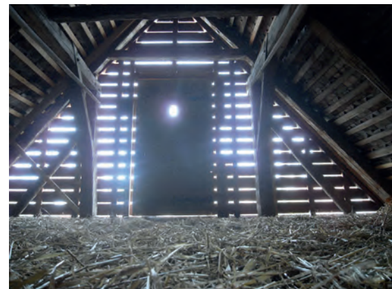
Abb. 110: Instandsetzung des Daches, strohgedämmte Geschößdecke | Lehmhaus Mitterretzbach | Andi Breuss | 2009
