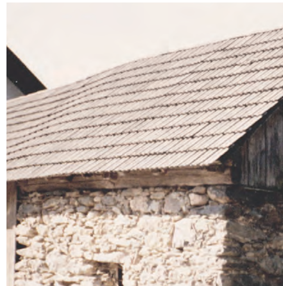
Abb. 30: Granitmauerwerk. Prannleithen-Hof in Yspertal
