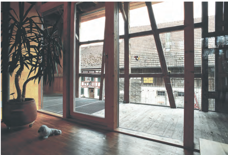
Abb. 105: Holzbretterfassade vor privater Veranda in geschlossener und geöffneter Position von innen
