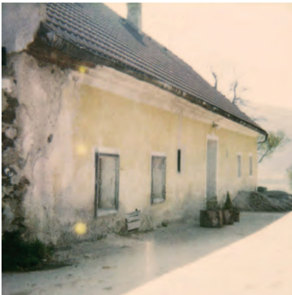
Abb. 29: Geringer Dachüberstand und Gesims. Prannleithen-Hof in Yspertal
