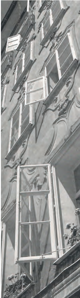
Abb. 33: lebendige Erscheinung der Fassade als Zeugnis des Lebens der BewohnerInnen
