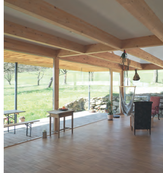
Abb. 106: Moderne Ausgestaltung einer Holzbalkendecke | Steinhaus Grub am Ostrong | Franz Schartner
