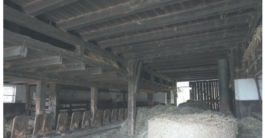
Abb. 156: Scheunendurchfahrt mit erhöhtem Mittelteil
