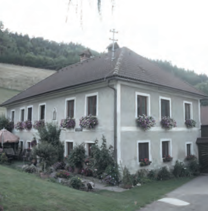
Abb. 87: Wohnhaus Vierseithof in Yspertal
