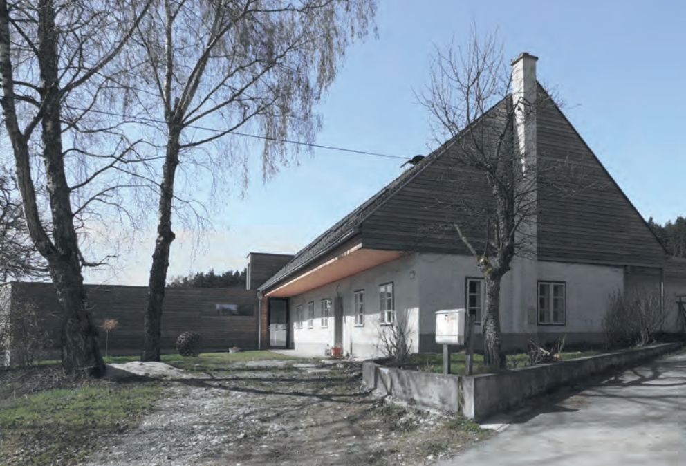
Abb. 78: Instandsetzung Steinhof am Ostrong | Franz Schartner | unten: Vorzustand | links: revitalisiert
