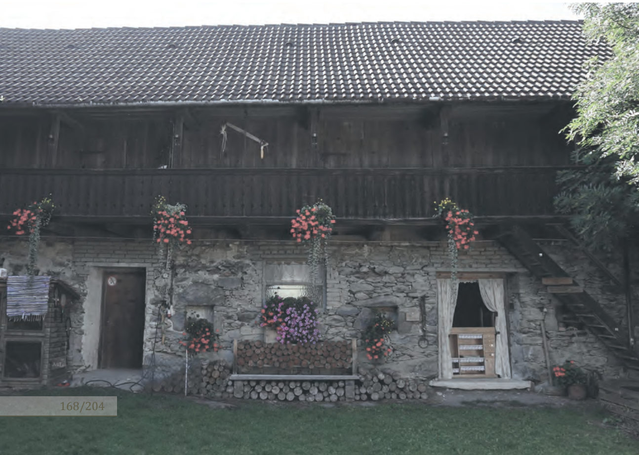
Abb. 153: Der ehemalige Stall, Hofansicht
