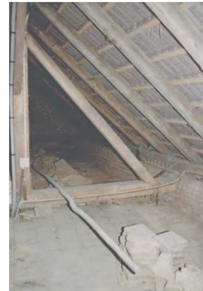
Abb. 107: Bestehende Dachhülle eines bäuerlichen Wohnhauses
