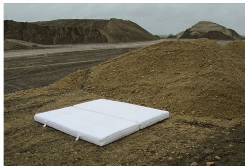
Abbildung 3-6: Einbau der Schwachstelle
