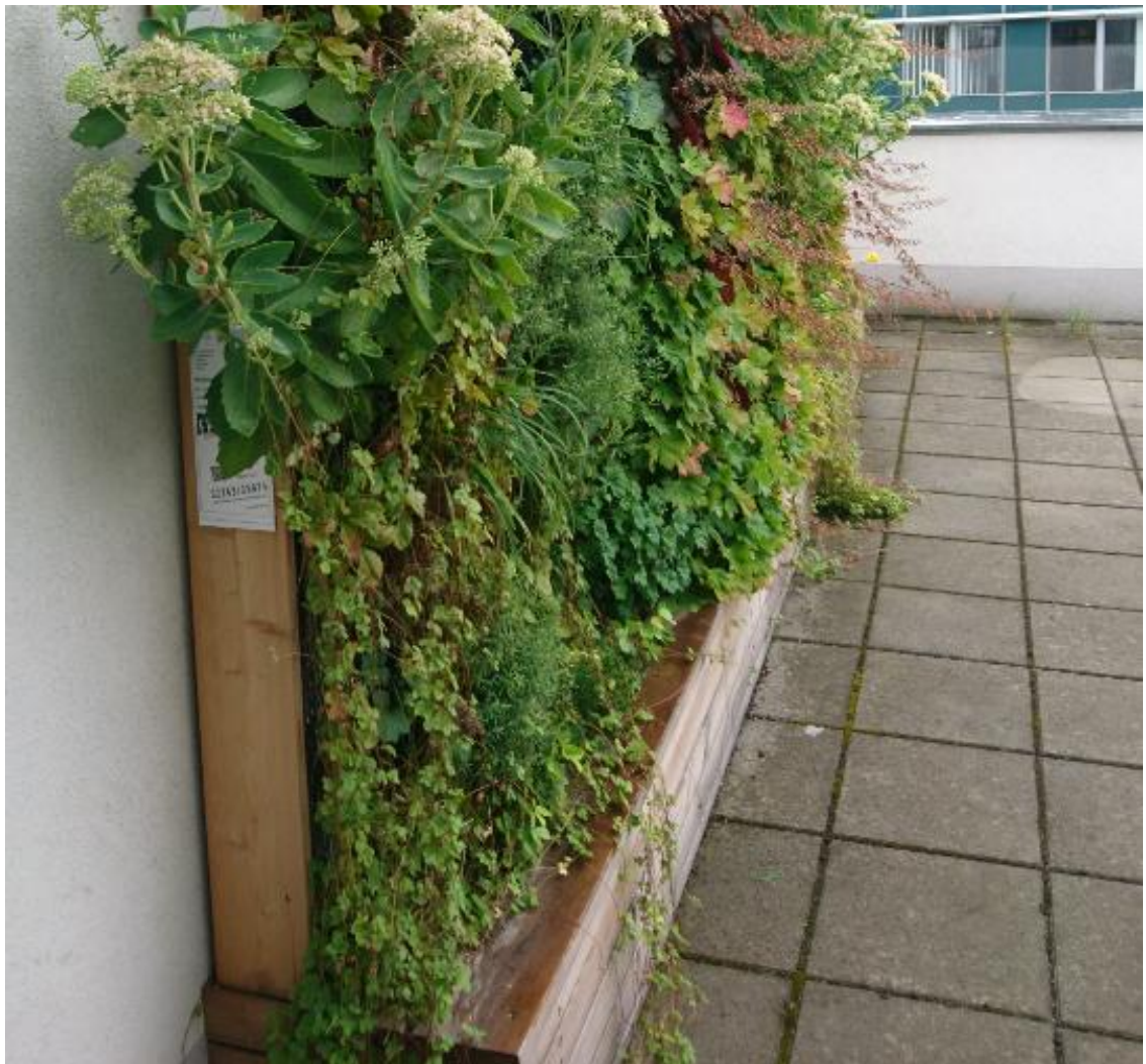
Abb. 81: Diefenbachgasse – seitliche Verkleidung der Begrünungskassetten
