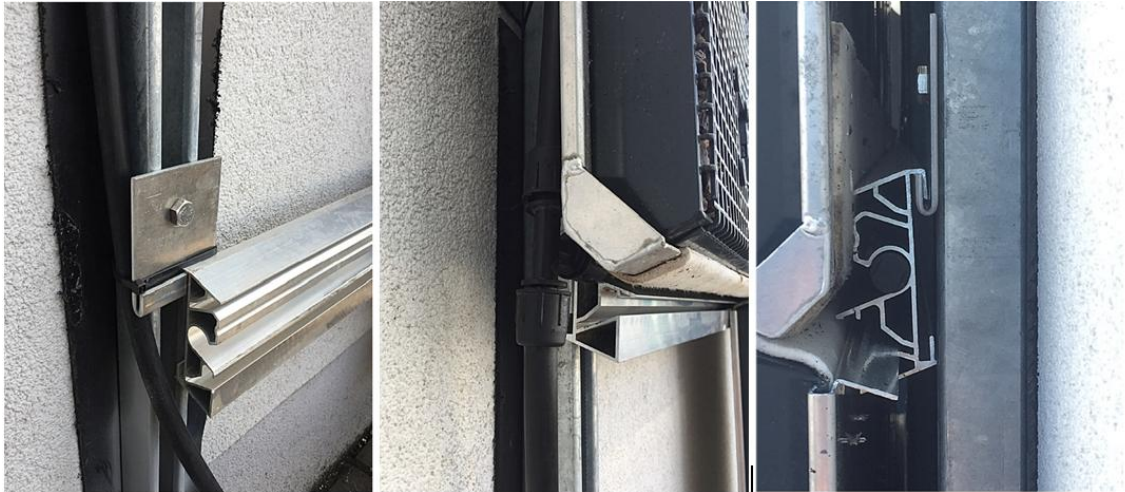
Abb. 65: Diefenbachgasse – Montage der Fassadenbegrüung (2)
