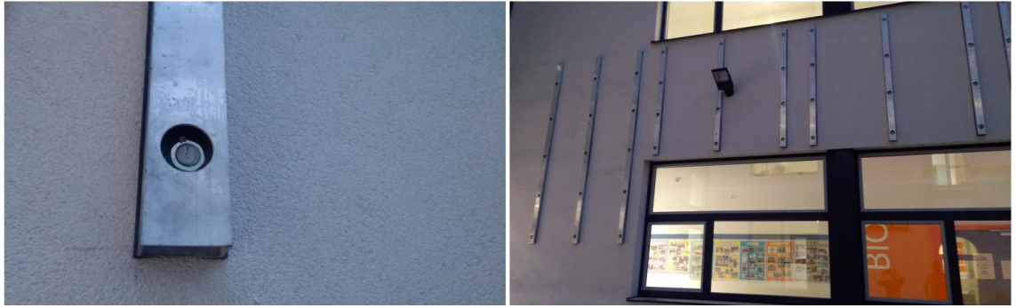
Abb. 68: Schumeierplatz – Montage der Fassadenbegrüung (1)
