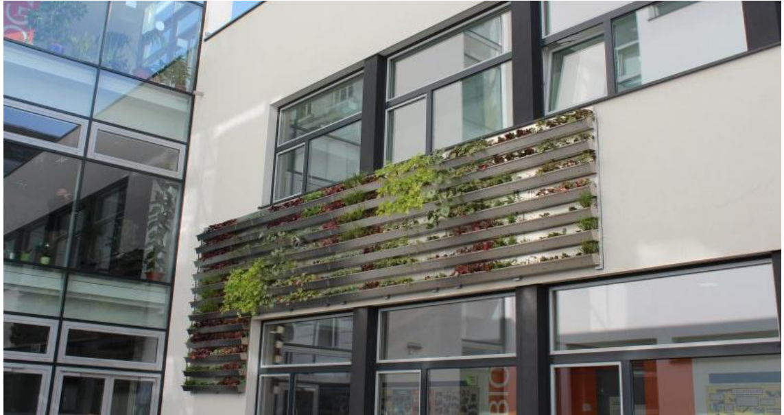
Abb. 67: Schumeierplatz – Fassadenbegrünung System Techmetall [GRU18b]
