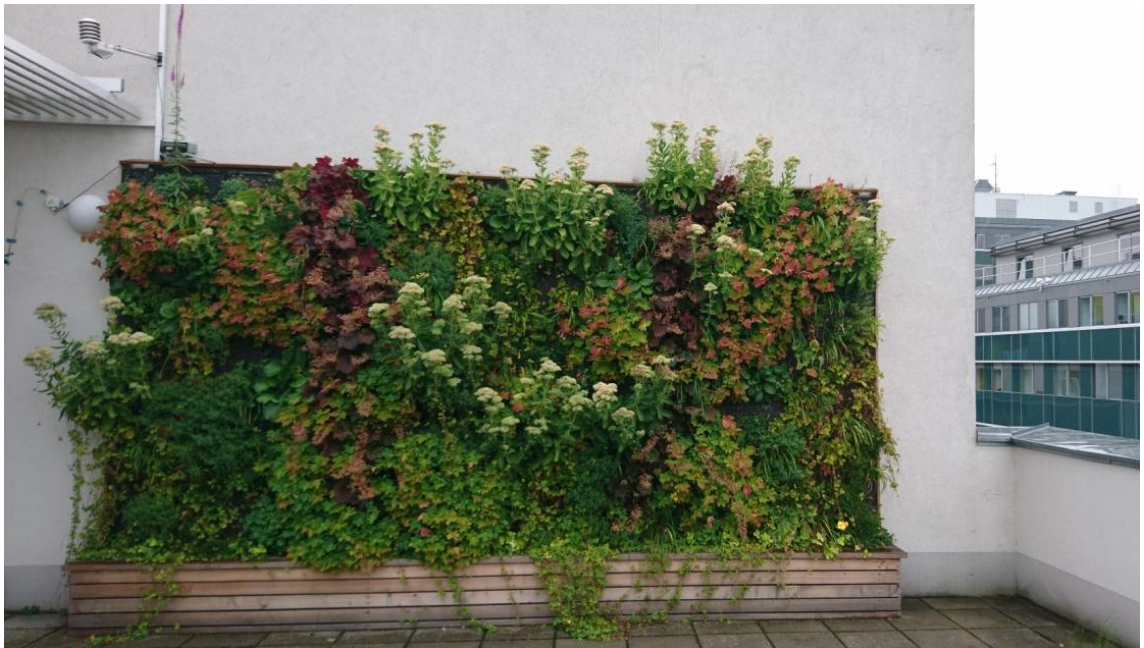
Abb. 62: Diefenbachgasse – Fassadenbegrünung System Optigrün®
