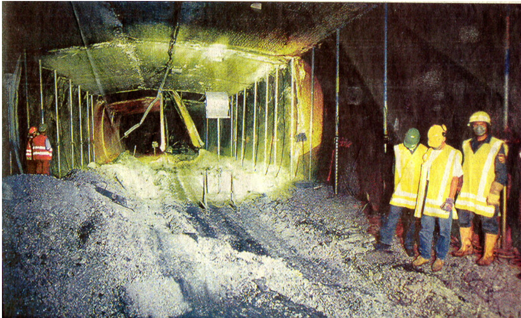
Abbildung 9: Zustand des Fahrtraumes nach der Fahrzeugbergung 55
