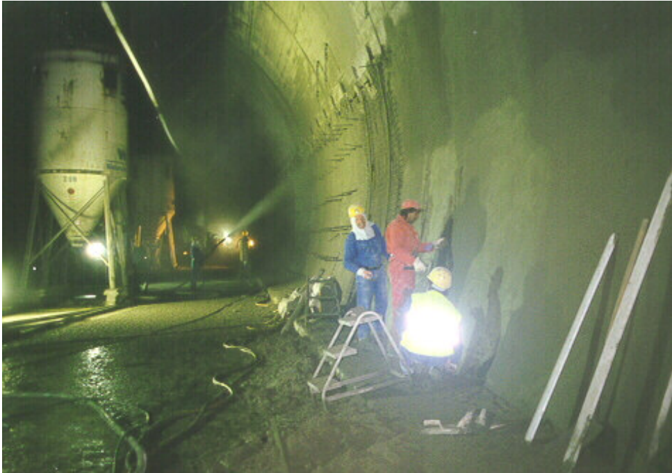
Abbildung 19: Spritzbetonarbeiten
