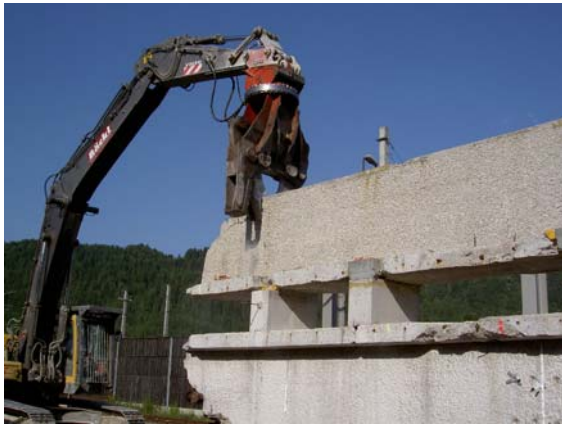
Abb. 8-23: Vorsichtiges Abzwicken des Trägers Nr.1 zum freilegen der Spannstähle
