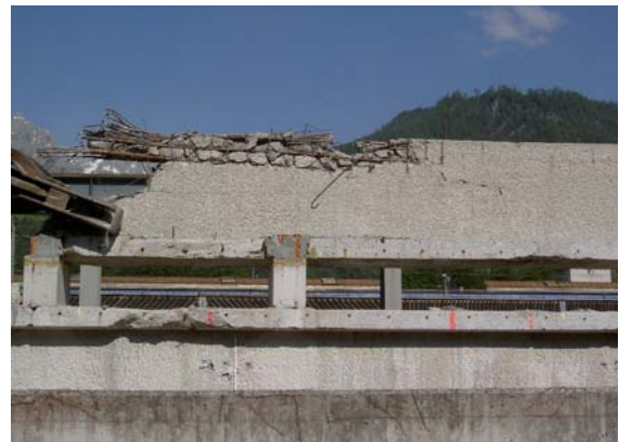
Abb. 8-28: Abzwickeln bis zum zweiten Auflager / Freilegen der nächsten Spannähle
