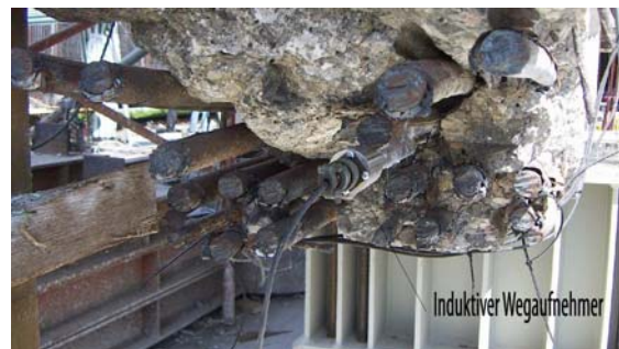
Abb. 3-6: Messung des Spannstahleinzugs
