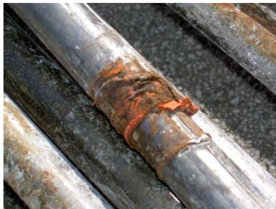
Abb. 2-9: Guter Zustand der Hüllrohre
