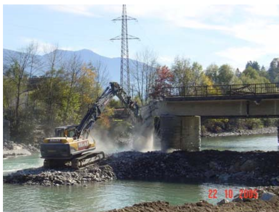
Abb. 2-1: Abbrucharbeiten des östlichen Teils des Tragwerks
