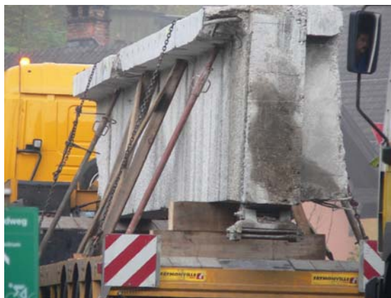
Abb. 2-4: Sicherung des Trägers auf dem Tieflader
