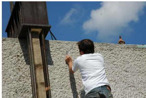
Abb. 4-6: Dokumentation Rissverlauf Versuch Nr. 1, Träger Nr. 1, gestuckte Trägerseite
