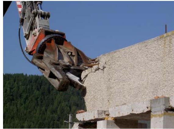
Abb. 8-23: Vorsichtiges Abzwicken des Trägers Nr.1 zum freilegen der Spannstähle
