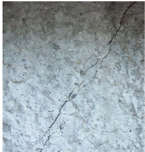
Abb. 8-21: Rissdetail Träger Nr.2 gestuckte Trägerseite
