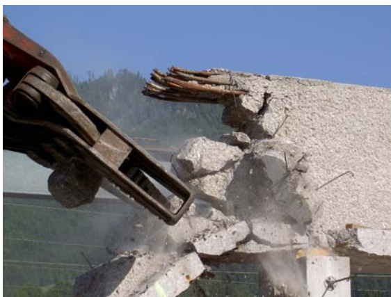
Abb. 8-24: Spannstähle ca. 1,50 m freigelegt
