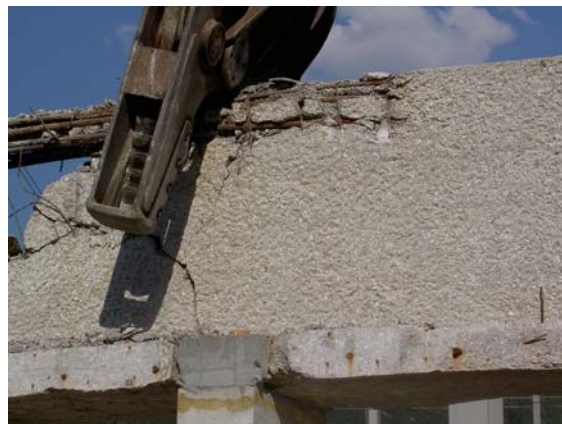
Abb. 8-25: Abzwicken der Spannstähle
