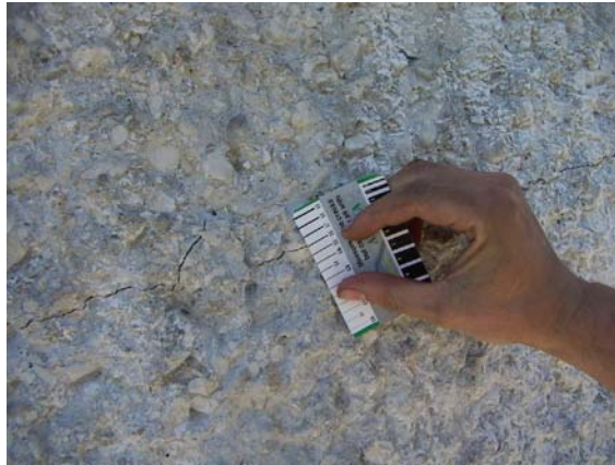
Abb. 4-4: Rissbreitenmessung mittels Risssschablone
