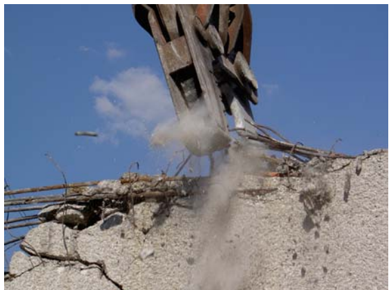
Abb. 8-25: Abzwicken der Spannstähle
