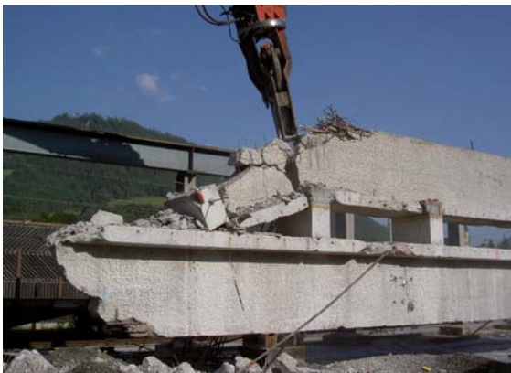
Abb. 8-28: Abzwickeln bis zum zweiten Auflager / Freilegen der nächsten Spannähle
