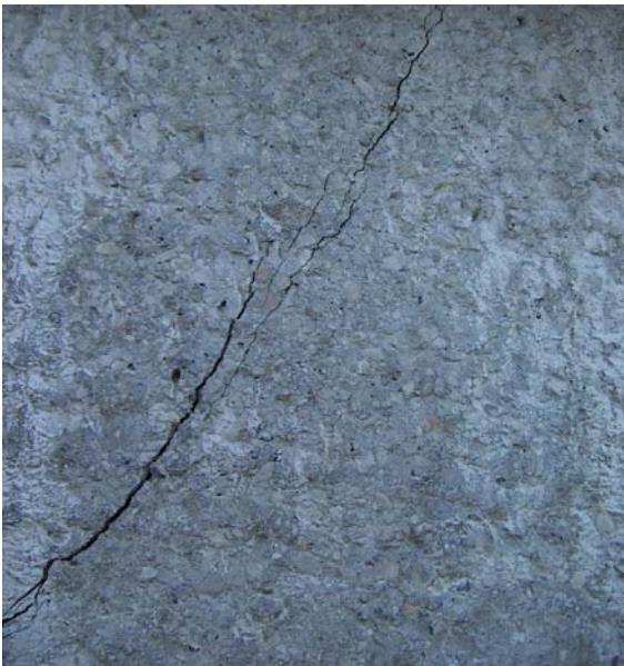
Abb. 8-21: Rissdetail Träger Nr.2 gestuckte Trägerseite
