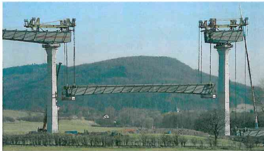
Abbildung 1.1: Einheben des Stahltragwerks; [12]
