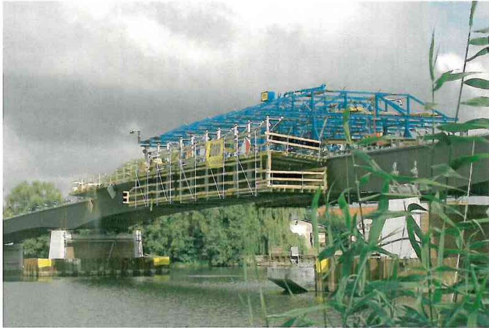
Abbildung 9.2: Verbundbrücke im Bauzustand; [13]
