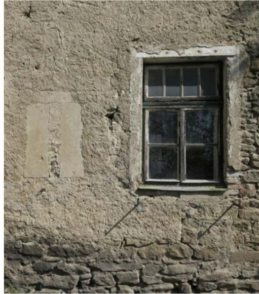
Abb. 25 Li. Ehemalige gequaderte Öffnung, Re. Fenster mit Oberlichte, Südfassade
