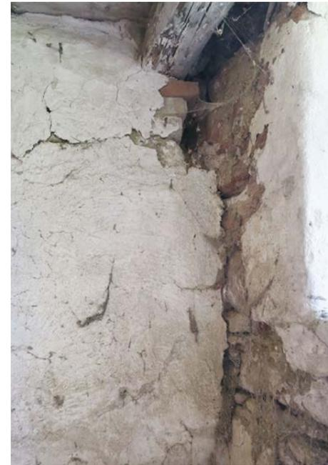
Abb. 172 Stumpfer Anschluss, Nord-West Ecke
