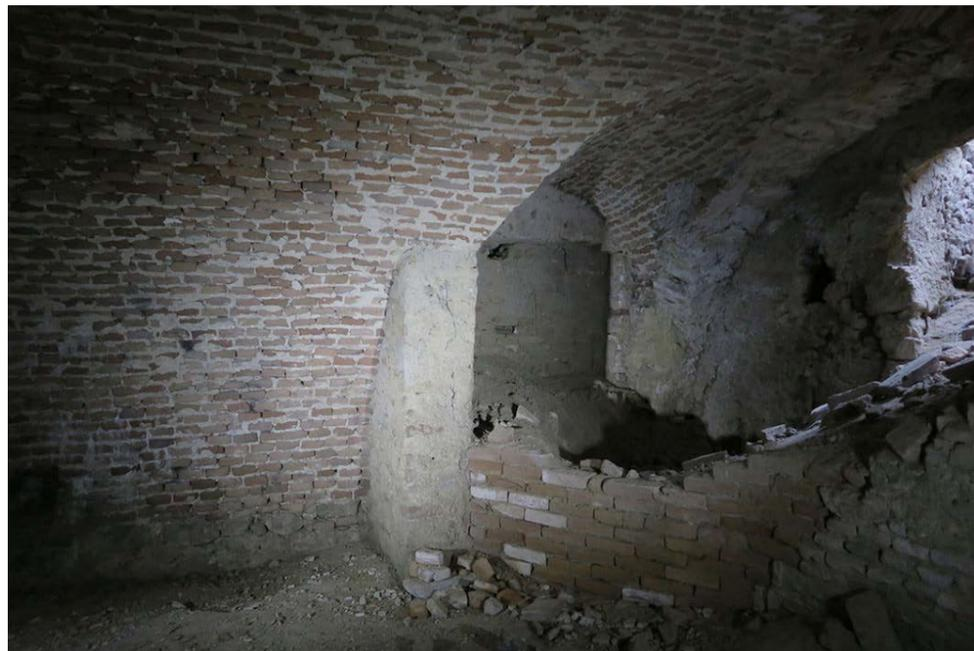
Abb. 94 Stichkappe über einer ausgemauerten Öffnung, Nordwand
