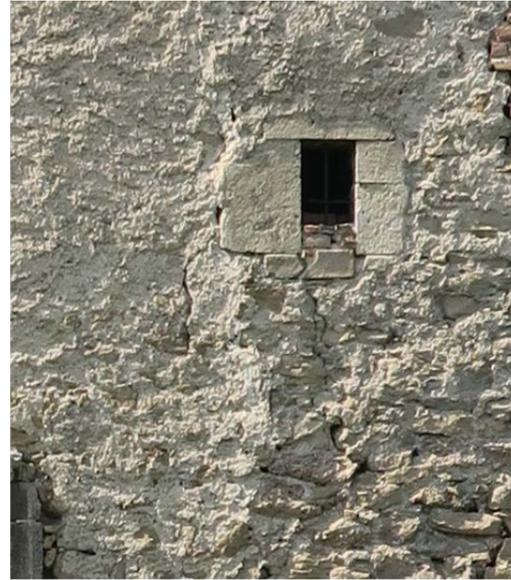
Abb. 26 Gequaderte spätmittelalterliche Öffnung, Ostfassade
