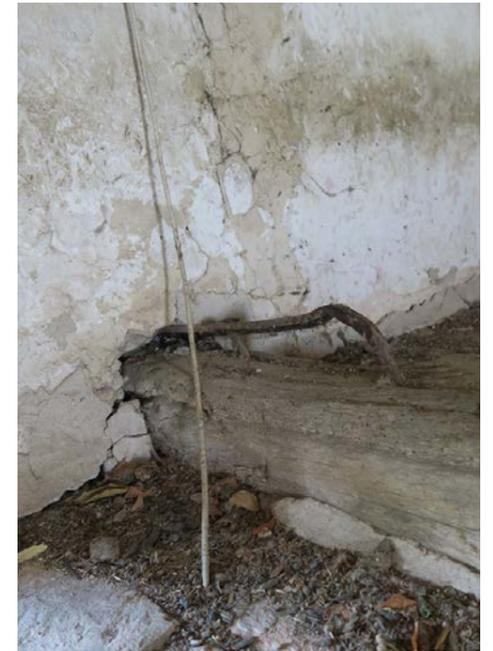
Abb. 192 Rückverankerung des Zugankers
