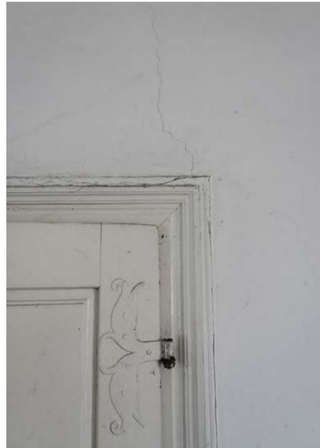
Abb. 139 Verziertes Metallband, Türe zu EG.07, Westwand
