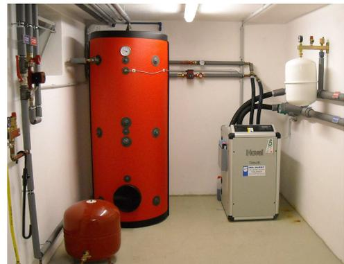
Abb. 111: Wärmepumpe und Pufferspeicher
