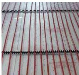
Abb. 47: Verlegung mit Klippleisten [54]
