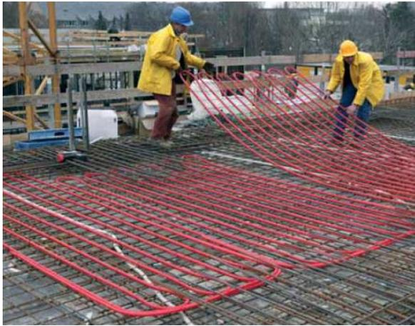
Abb. 55: Verlegung von Rohrmodulen [64]
