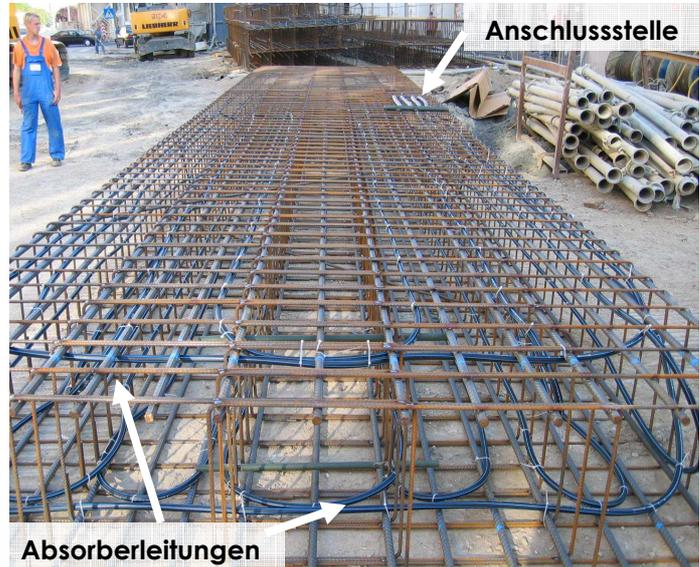
Abb. 22(oben): Schlitzwandkorb mit Absorberleitungen [7]
