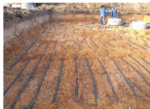
Abb. 7: Herstellung eines Flächenkollektor [71]
