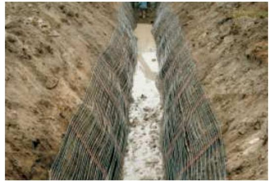
Abb. 11: Herstellung eines Grabenkollektors [59]
