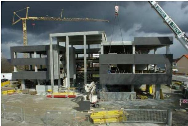
Abb. 106: Bürogebäude Trepka in Betonfertigteilbauweise, Bauzustand [20]
