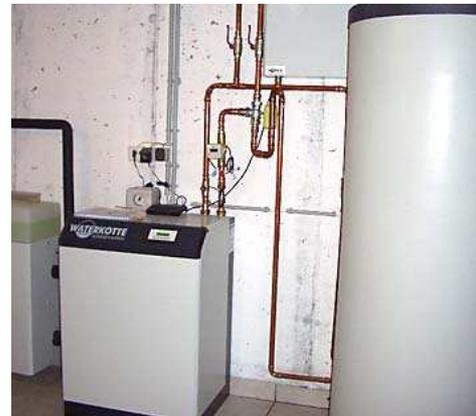
Abb. 87: Wärmepumpe und Pufferspeicher [56]
