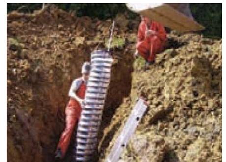
Abb. 13: Einbau eines Svec-Kollektors [67]
