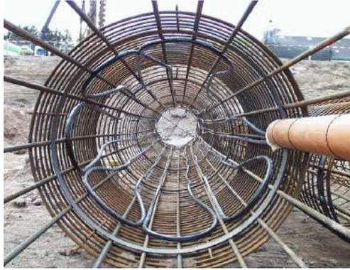
Abb. 19: am Bewehrungskorb befestigte Absorberrohre [2]
