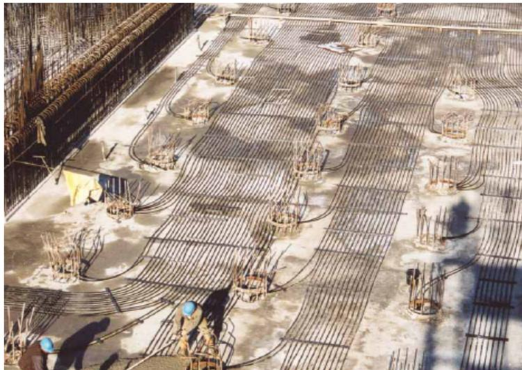
Abb. 28: Energiebodenplatte (in Kombination mit Energiepfählen), Absorberleitungen [7]
