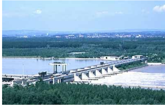
Abbildung 4 : Donaukraftwerk Ybbs-Persenbeug. [BMLFUW]
