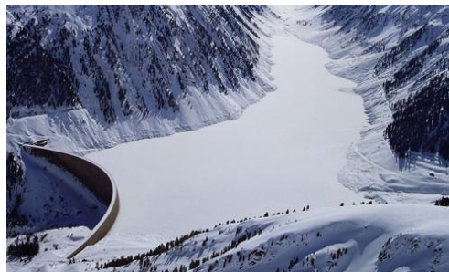
Abbildung 5 : Speicherkraftwerk Zemm-Ziller [die Presse, 2009]
