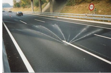
Abbildung 2.19: Taumittelsprühanlage
