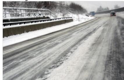
Abbildung 6.5: Schnee in der Rollspur
