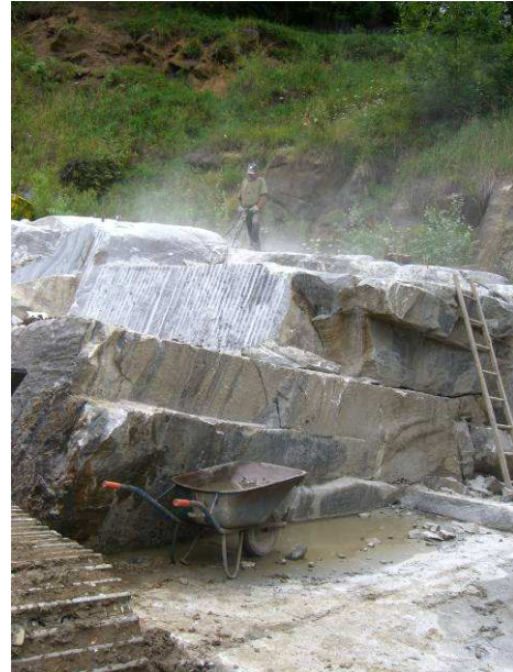
Abb. 9: Abbautechnik „Loch neben Loch“ mit Pressluftschlägern.
