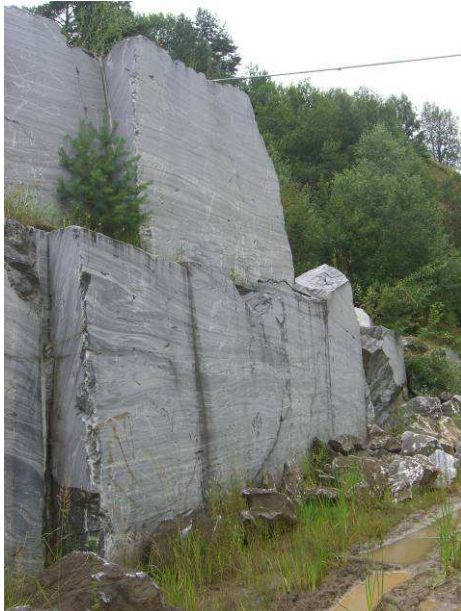
Abb. 8: Im Seilsägeverfahren hergestellte Abbauwand.
