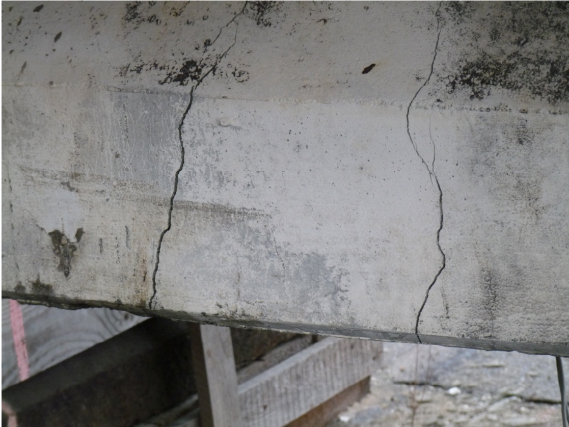
Abbildung 74: Schubrisse bei Versuchende - Trägerrückseite
