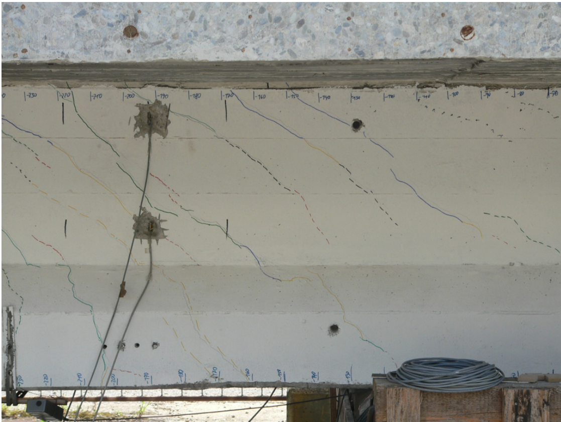
Abbildung 55: Rissbild bei Prüflast
