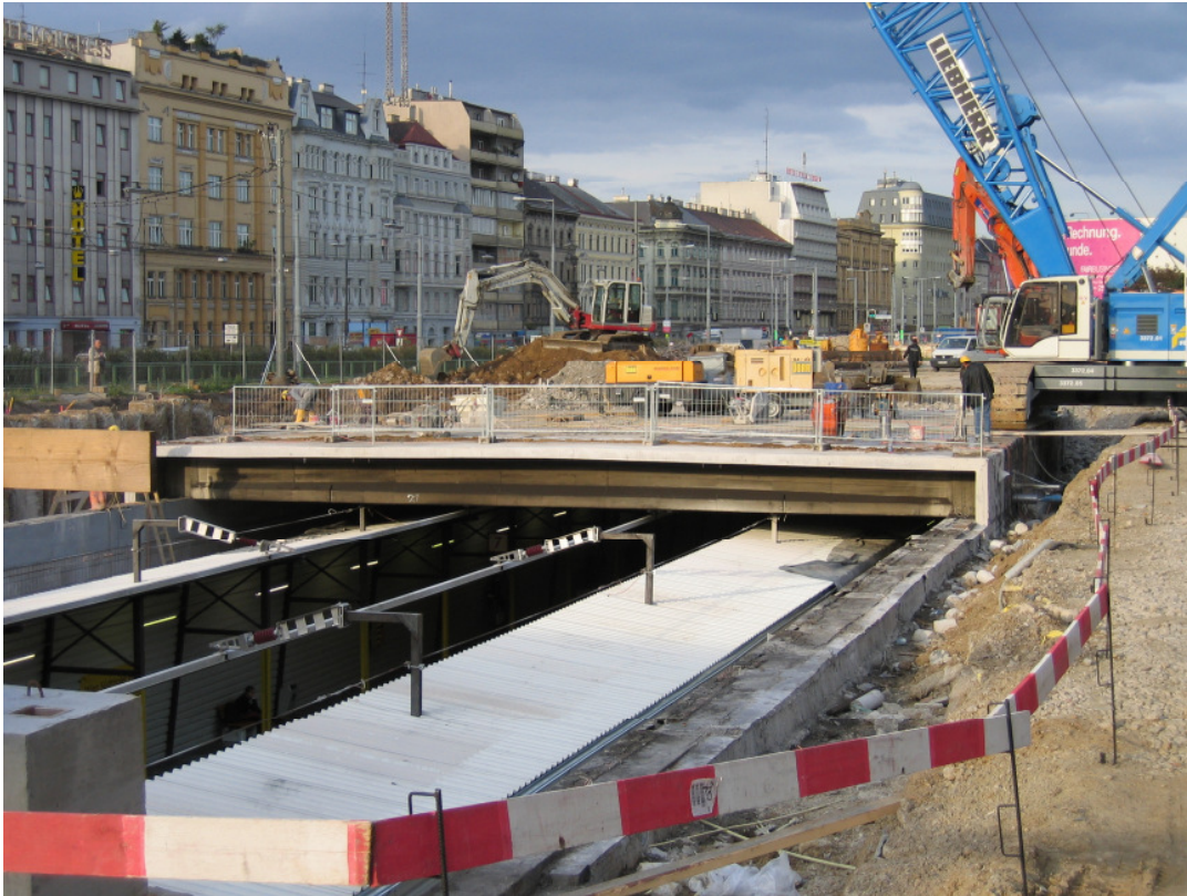
Abbildung 10: Brückenträger im eingebauten Zustand
