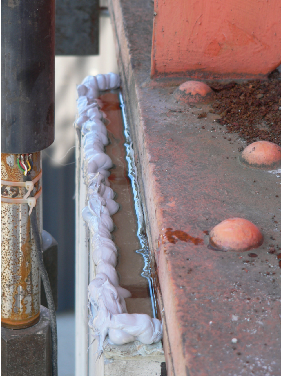
Abbildung 52: Lagerverguss
