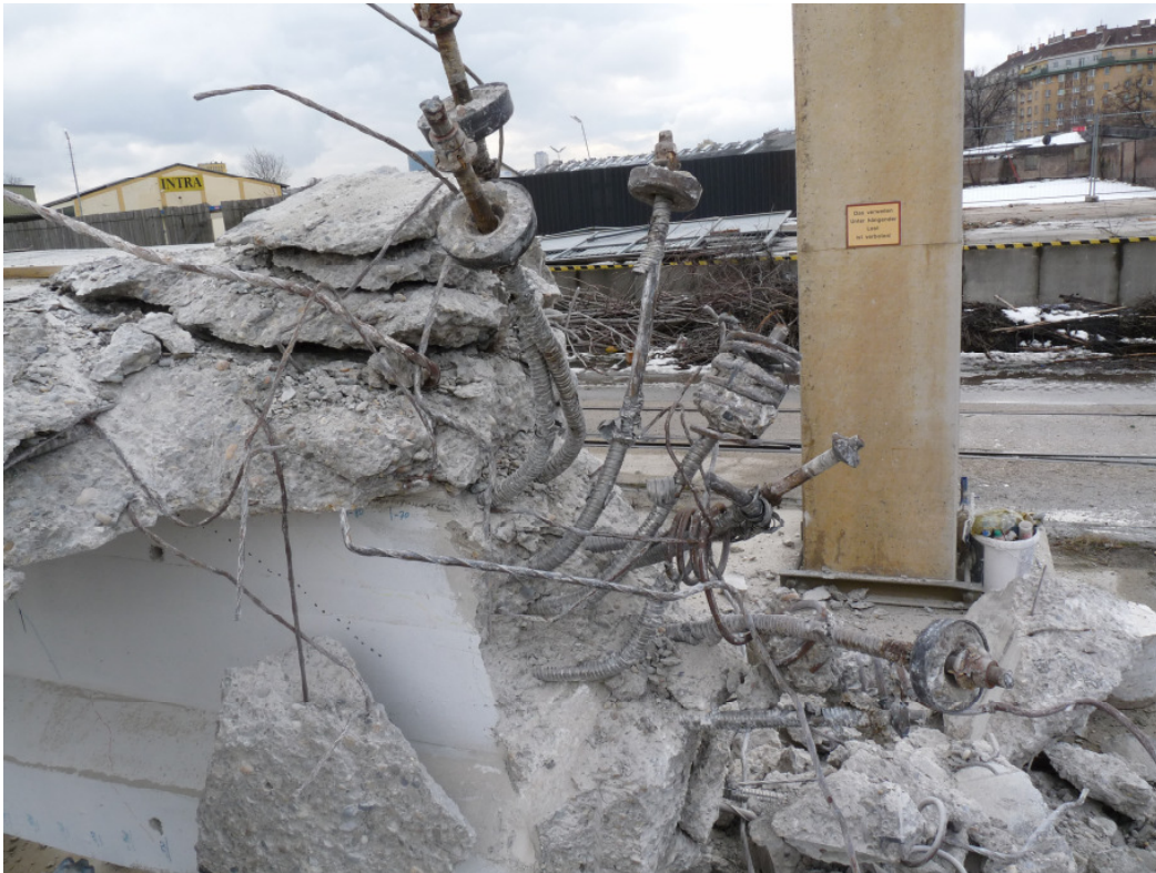
Abbildung 22: Spanngliedverankerung eines Versuchsträgers [10]
