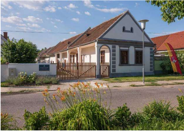
Abbildung 89: Tschardakenhof Straßenansicht (Quelle: Tschardakenhof, 2021)
