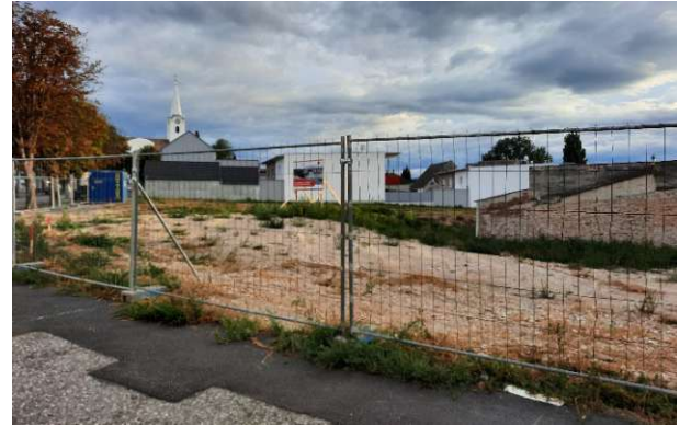
Abbildung 51: Baustelle Gesundheits- & Sozialzentrum, Sept. 2022 (eigene Aufnahme)
