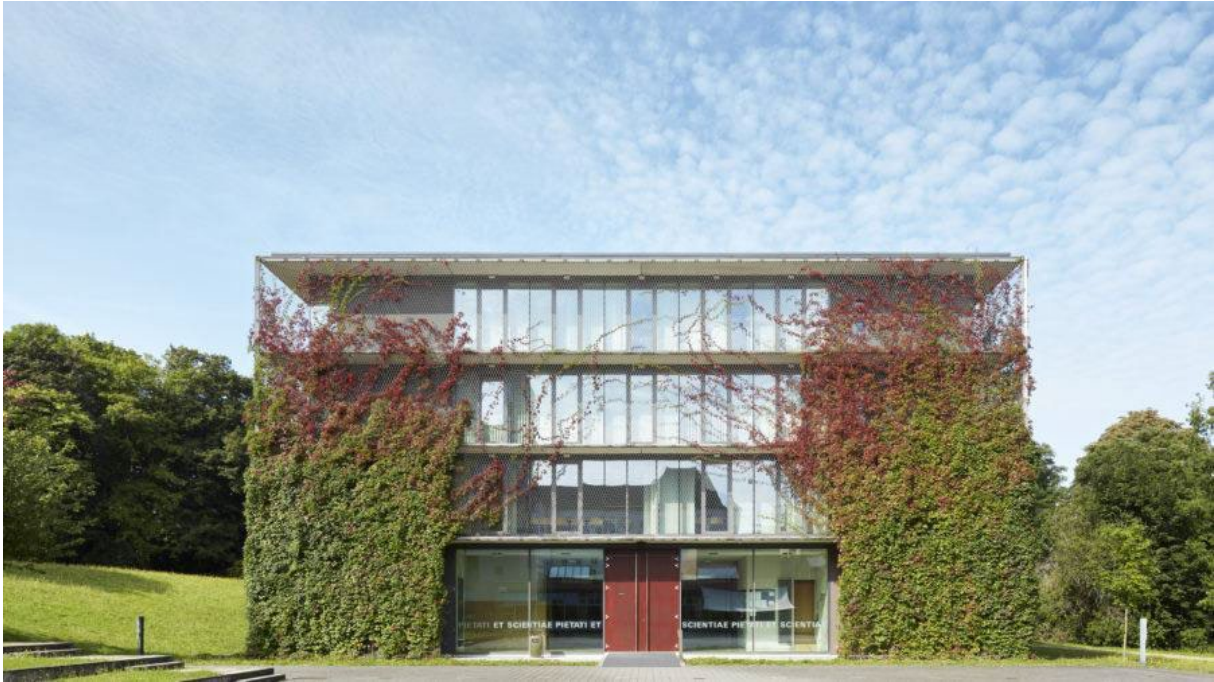
Abbildung 17: bodengebundene Fassadenbegrünung mit Ranknetz © Dietmar Strauß Besigheim
