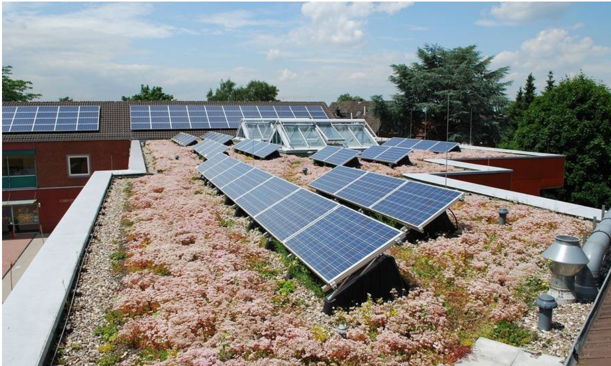
Abbildung 12: Solargründach © Optigrün
