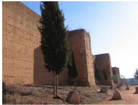
Abbildung 5 – Stadtmauer von Niebla
