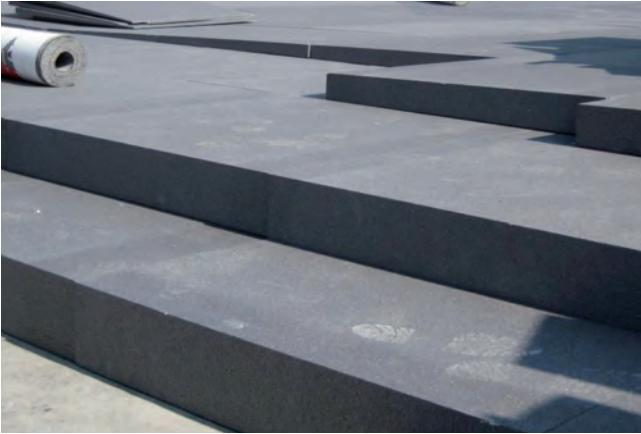
Abb.43. Dämmstärken auf dem Dach bis 45cm
