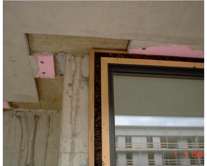
Abb.48. Blindstockmontage - das Fenster sitzt vollständig in der Dämmebene
