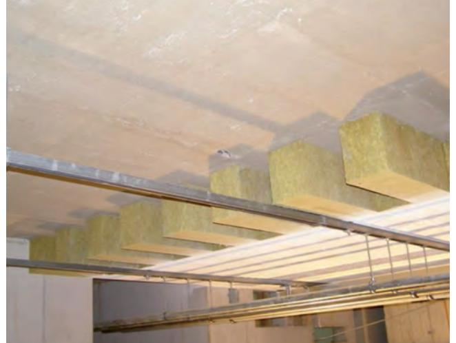
Abb.46. Dämmstärken an Decken und Wänden
