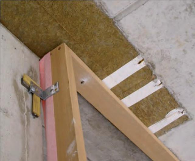
Abb.47. Blindstockmontage - das Fenster sitzt vollständig in der Dämmebene
