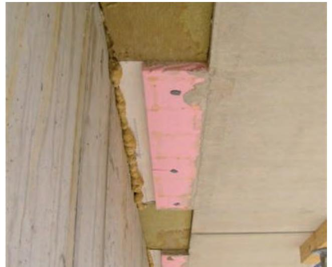
Abb.50. thermische Trennung der Balkone
