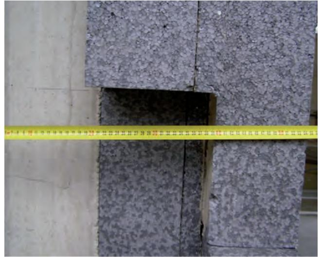
Abb.44. Dämmstärken der Fassade bis 30cm
