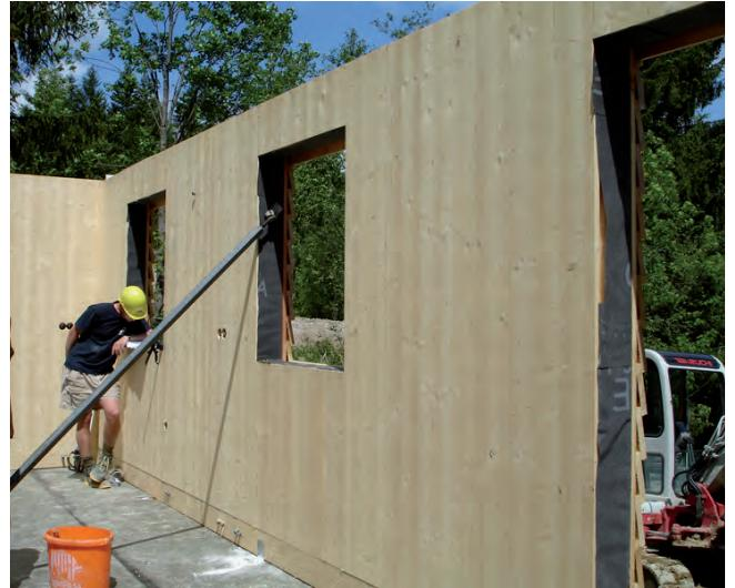
Abb.68. Außenwände von Fa. Binderholz vorgefertigt inkl. Fassade, Dämmung u. E-Installationen
