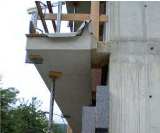
Abb.49. thermische Trennung der Balkone
