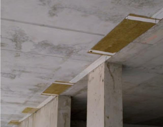
Abb.45. thermische Trennung in der TG mittels Iso-
