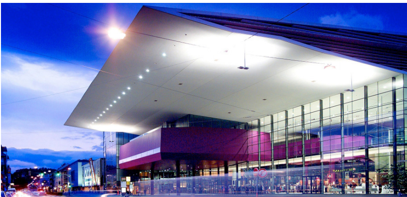
Abb.B.II-3 Foto Stadthalle Graz
