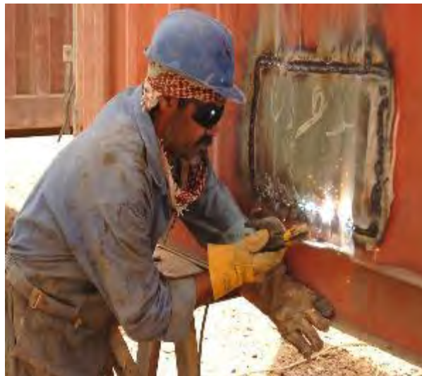
Abbildung 3.20 Reparatur eines Containers
