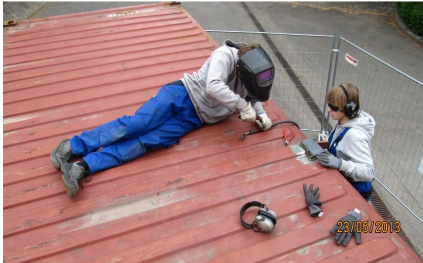
Abbildung 5.11 Anschweißen des Auflagerpunktes (Mobiles Stadtlabor)
