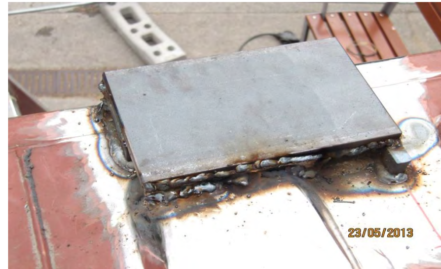
Abbildung 5.12 Nahaufnahme des Auflagerpunktes
