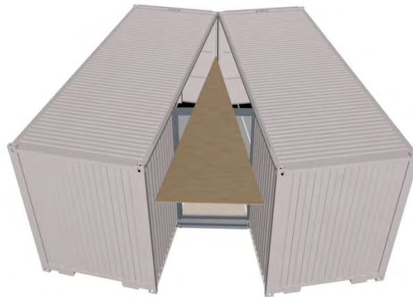
Abbildung 5.9 Deckplatte (Sperrholzplatte) wird zum Abschluss hineingeschoben
