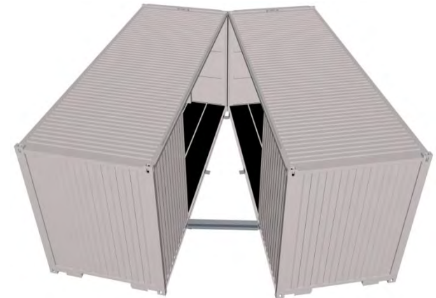
Abbildung 5.4 Träger wird eingelegt und an den L-Profilen befestigt
