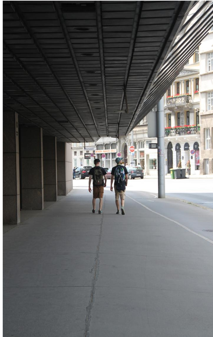
Abb. 26: Auskragung des Bestandsgebäudes
