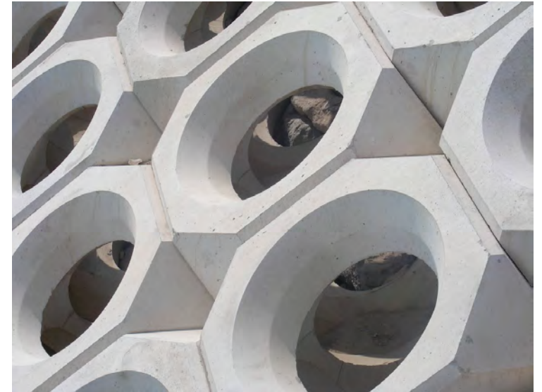
Abb. 21 Wellenbrecher Burj Al Arab – Detail
