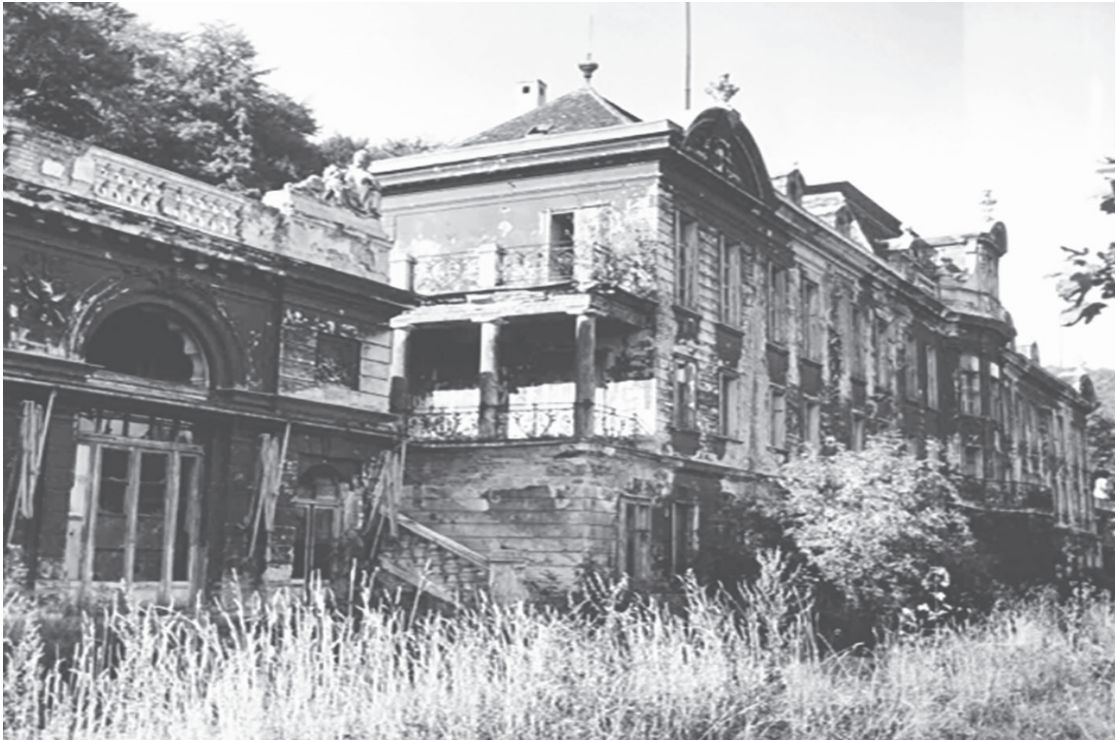
Abb. 054 Das Schloss Cobenzl - vor dem Abbruch
