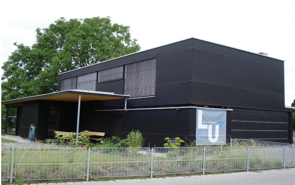
Abb. 39: PE-HD Fassade Lustenau
