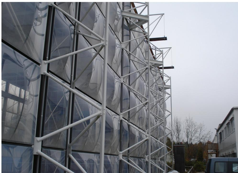
Abb. 41: ETFE Fassade Bad Tölz
