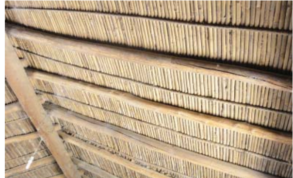
traditionelle Hütte : Dach 1.28
