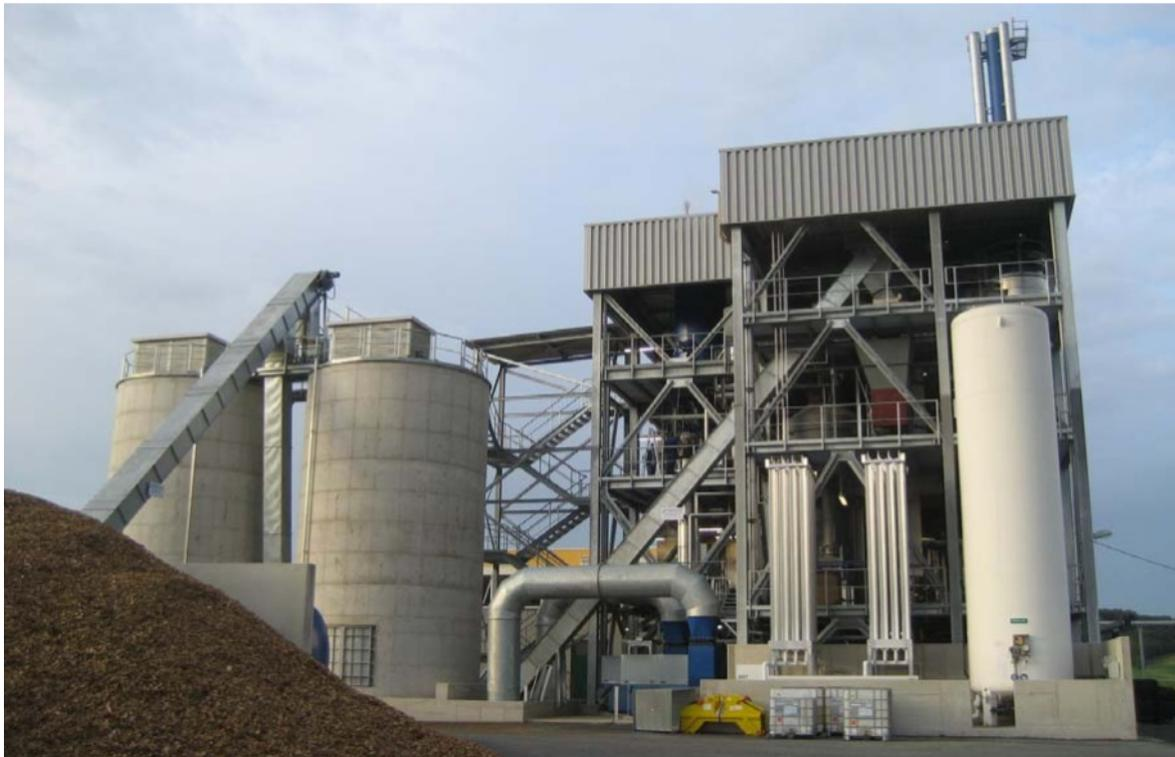
Abb 34: DFB-Vergasungssystems des Biomassekraftwerks in Oberwart
