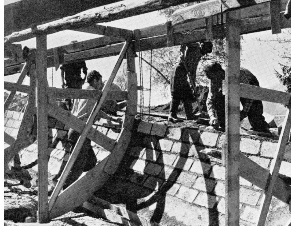
Abb.99 Ausbau der Bobbahn in Igls für die IX. Olympischen Winterspiele 1964
