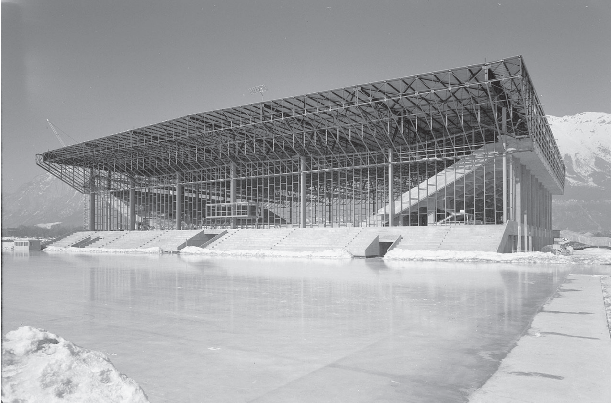
Abb.81 Das Olympiaeisstadion im Bau, 1963
