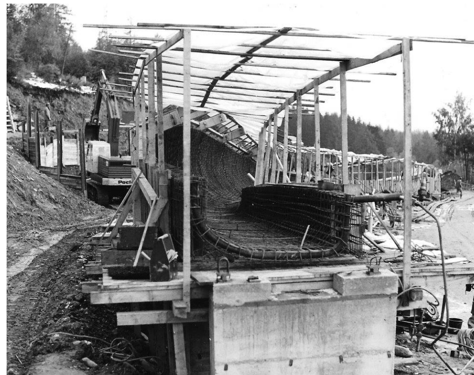
Abb.100 Bahnausbau der kombinierten Bob-, Rodel- und Skeletonbahn für die XII. Olympischen Winterspiele 1976
