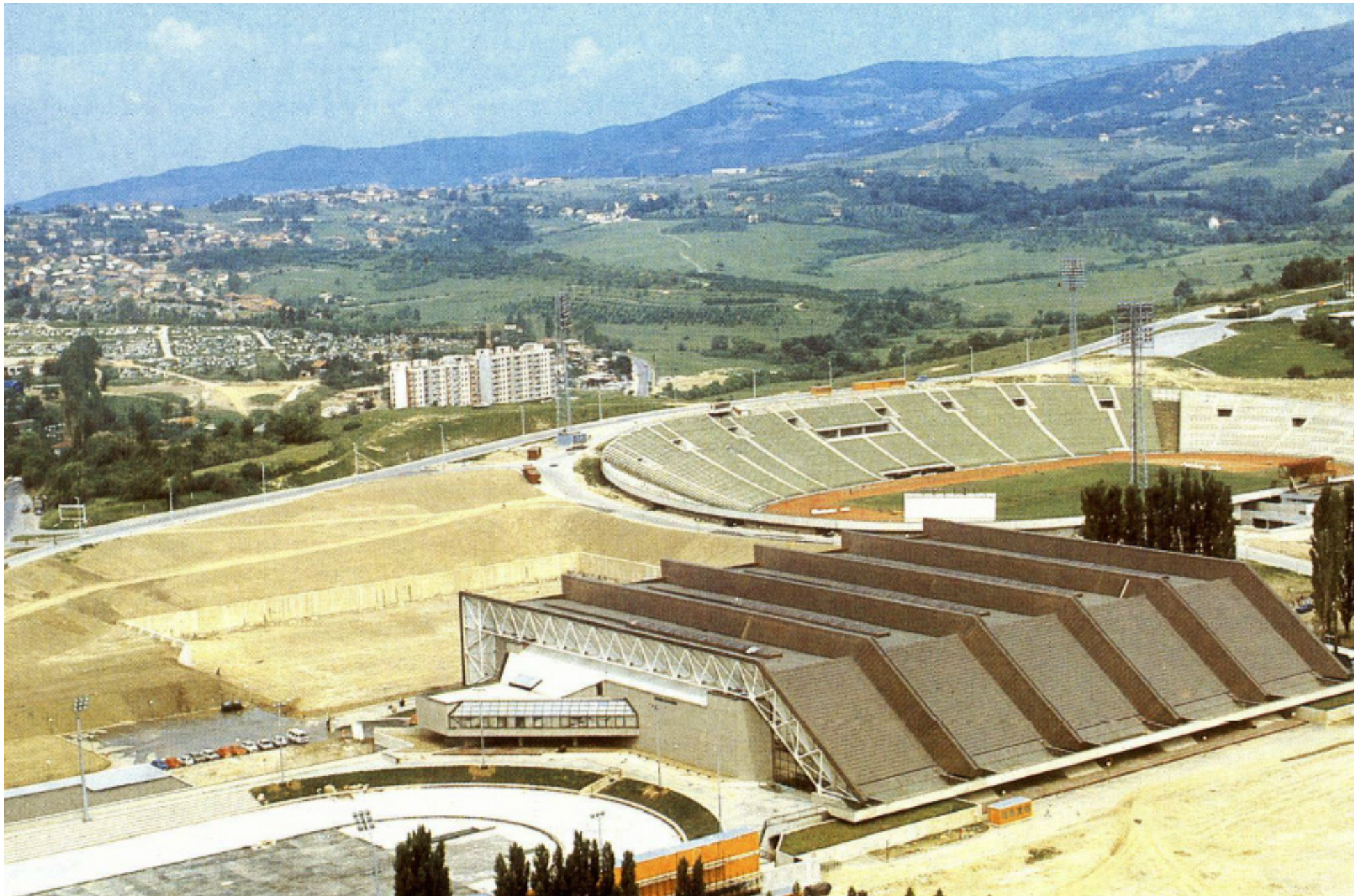
Abb.106 Eishalle Zetra im Vordergrund, Stadion Koševo im Hintergrund, im Bau, 1981
