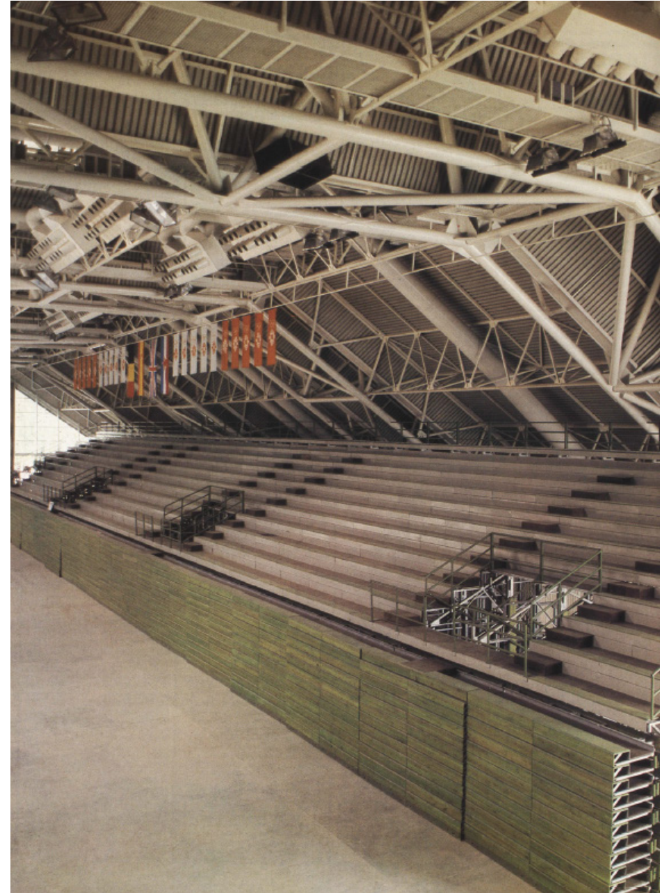
Abb.109 Tragkonstruktion der Eishalle Zetra, Innenraum, 1982
