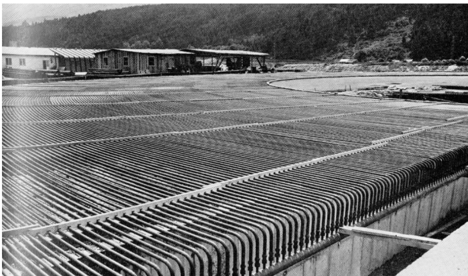
Abb.84 Die Eischnelllaufbahn im Bau, 1963
