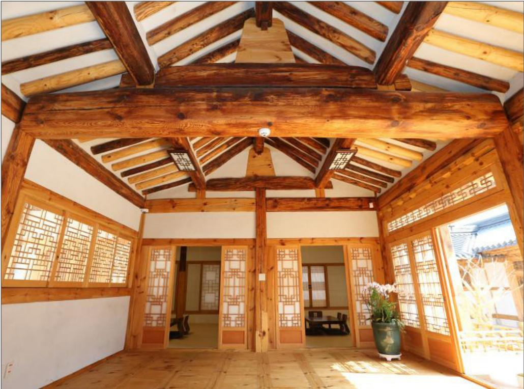
Abb. 4.19: Freiliegende Dachkonstruktion - 5-ryangga
